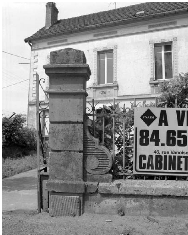
détail de la pile droite du portail d'entrée de la cour.
