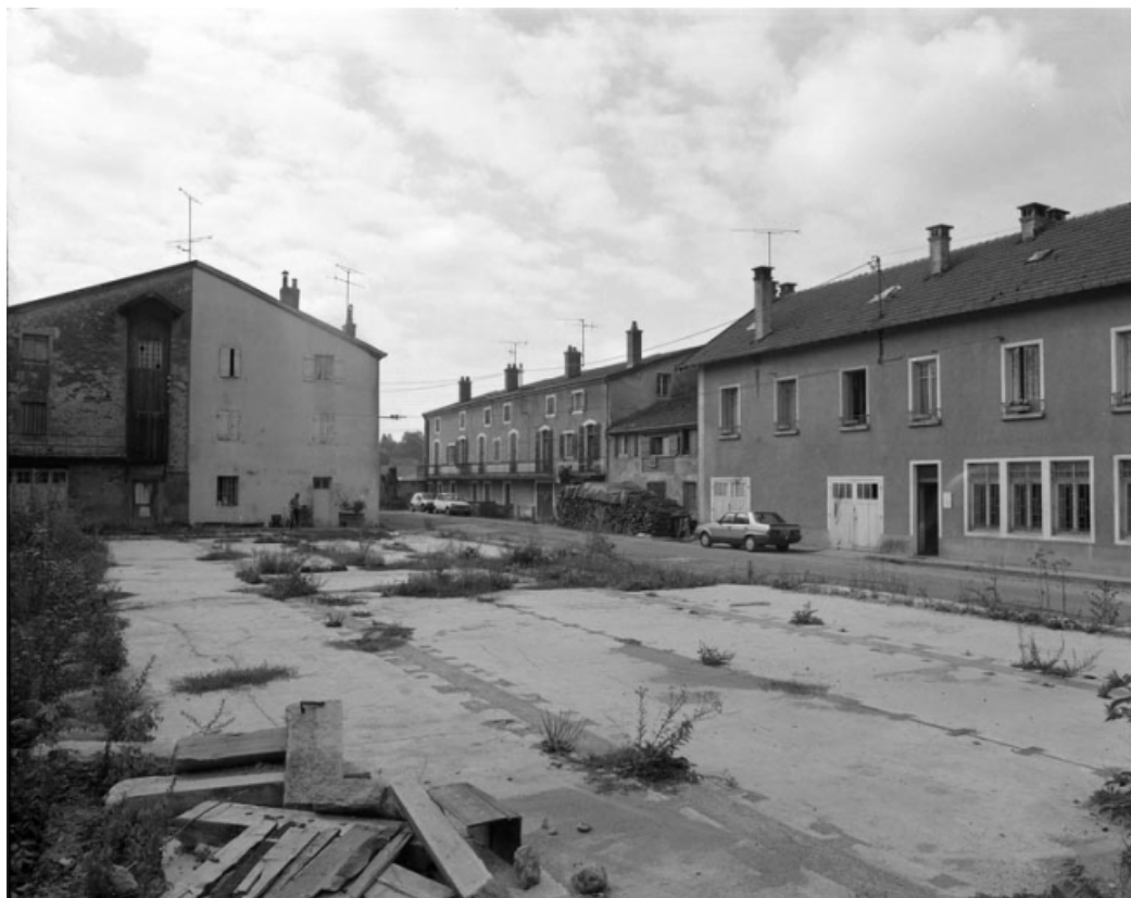
Vue des habitations de part et d'autre de la cour ; au premier plan traces d'un entrepôt détruit en 1988. 70, Gray, 6 quai Villeneuve
