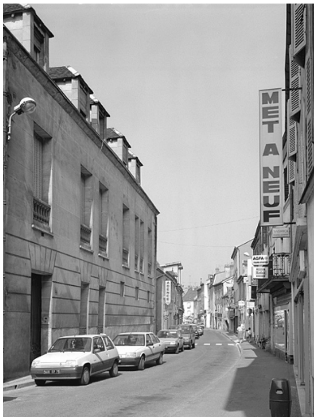
Façade antérieure de trois quarts gauche. 70, Gray, 54 rue Vanoise
