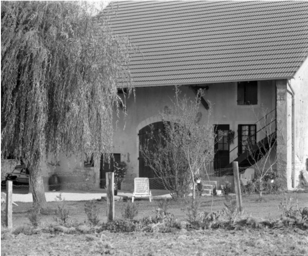
Vue de la façade antérieure de face.
