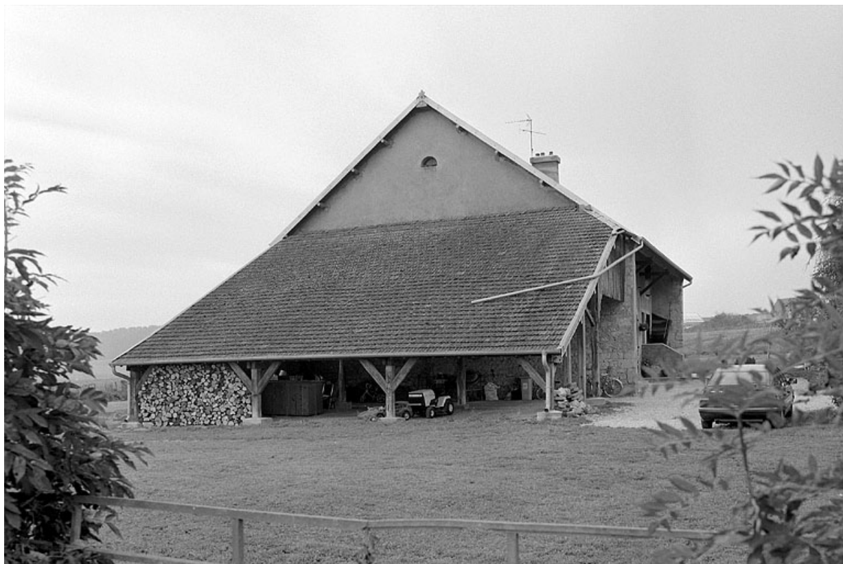
Vue de la façade latérale gauche de trois quarts droit.
