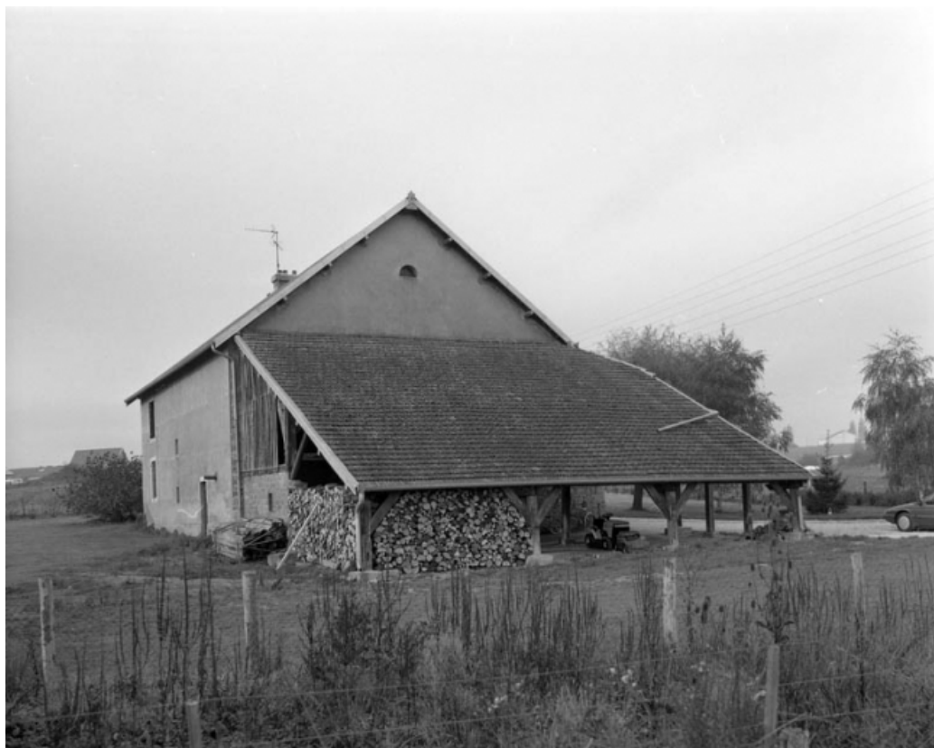
Vue des façades latérale gauche et postérieure, de trois quarts gauche.
