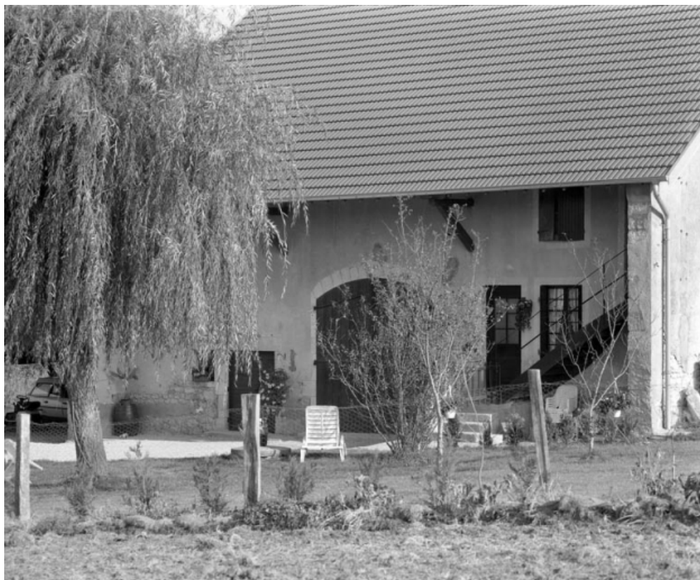
Vue de la façade antérieure de face.
