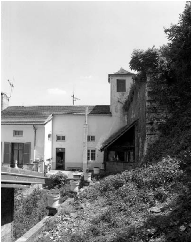
Détail : extrémité de l'aile sur cour.
