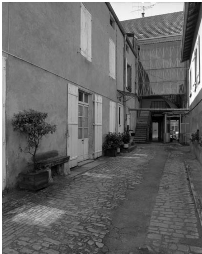
Façade postérieure de l'immeuble et logements dans la cour. 70, Gray, 69 rue Vanoise
