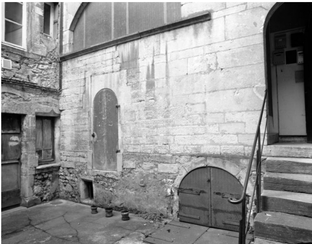
Corps de bâtiment contenant l'escalier : façade antérieure, partie inférieure. 70, Gray, 5 rue Vanoise
