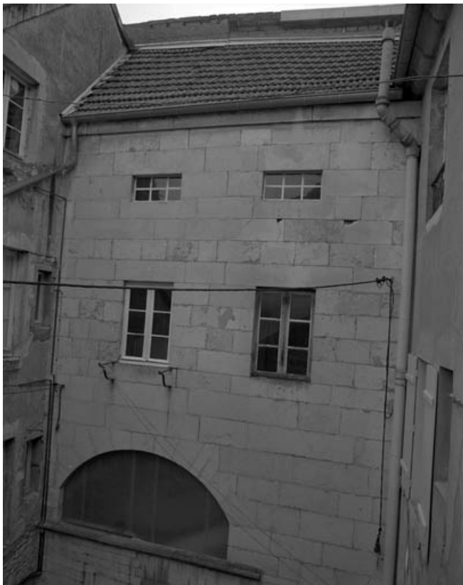
Corps de bâtiment contenant l'escalier : façade antérieure, partie supérieure. 70, Gray, 5 rue Vanoise
