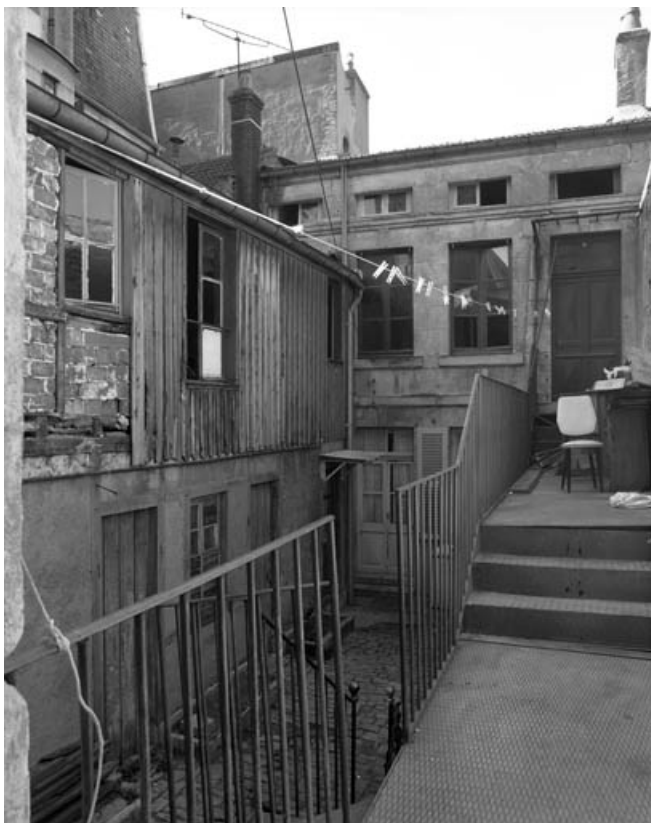
Bâtiment en fond de cour et aile gauche depuis la passerelle.
