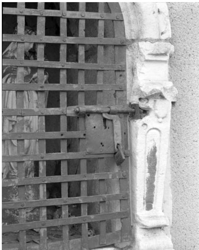
Détail d'une niche sur la façade latérale droite : système de fermeture. 70, Gray avenue De Gaulle
