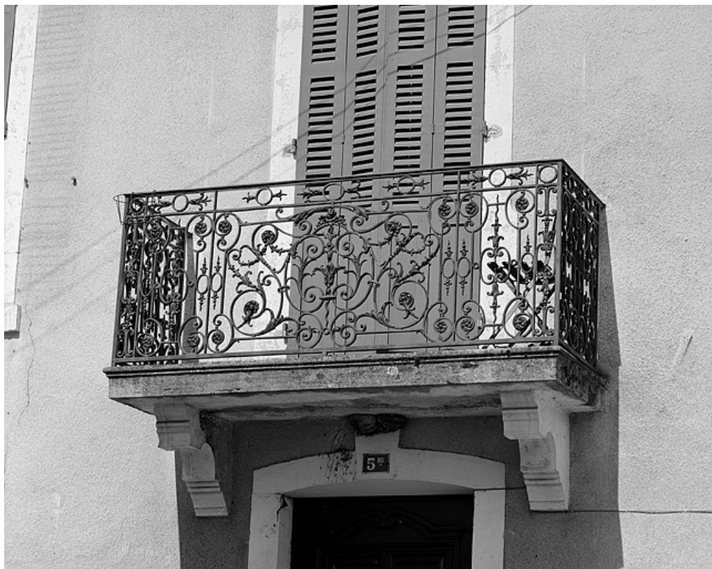
Détail : balcon en ferronnerie d'une baie du premier étage.
