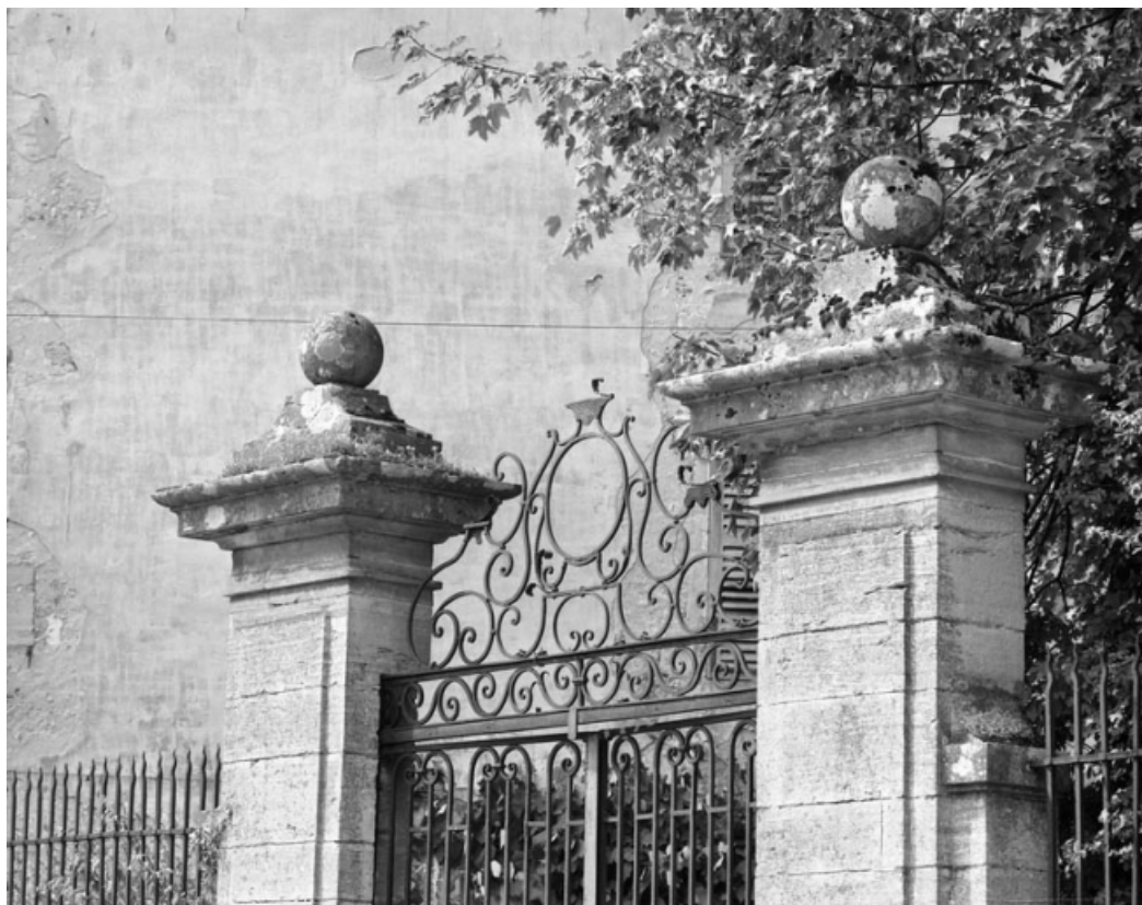
Grille d'entrée de la cour et du jardin : détail de la partie supérieure. 70, Gray, 17 rue des Casernes
