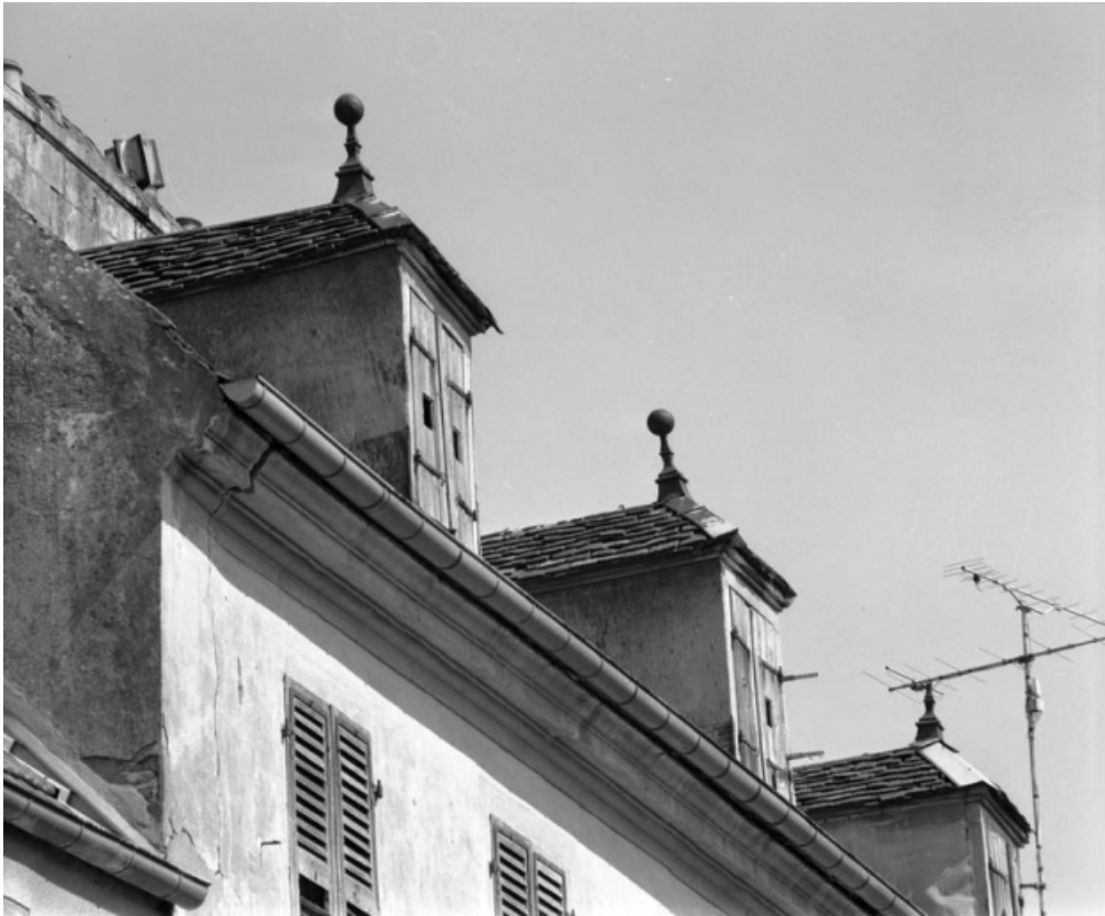
Façade antérieure : détail des lucarnes.
