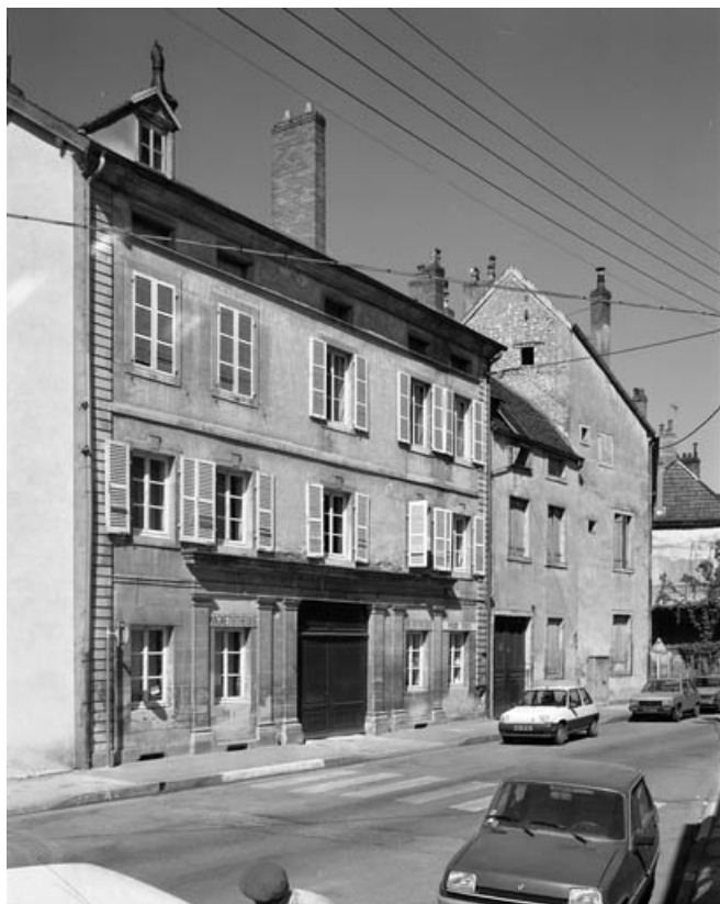
Vue d'ensemble de la façade antérieure de trois quarts gauche. 70, Gray, 6 rue des Casernes
