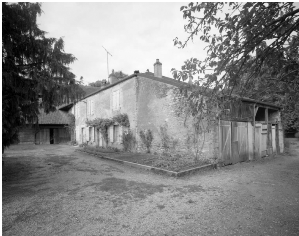
Logement annexe au fond du parc.
