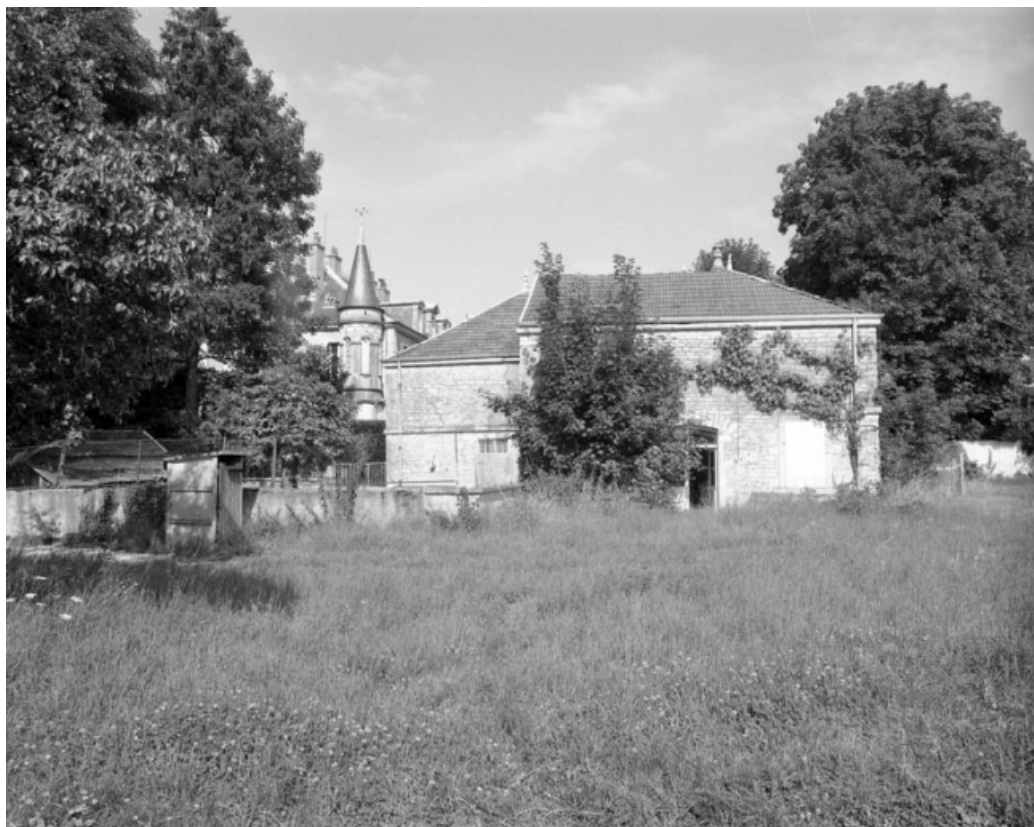
Façade postérieure de l'écurie depuis la cour des parties commerciales.
