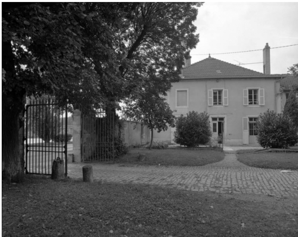
Entrée de la cour des parties commerciales avec l'ancien bureau à gauche. 70, Gray, 17, 18 quai Villeneuve
