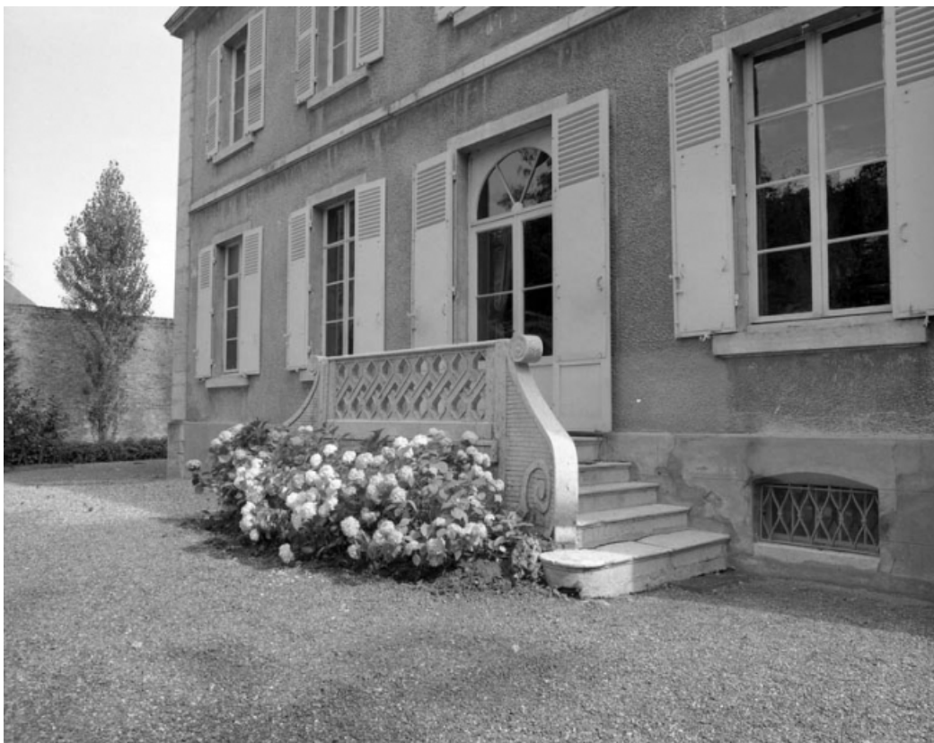
Détail : perron sur la façade postérieure de l'habitation.
