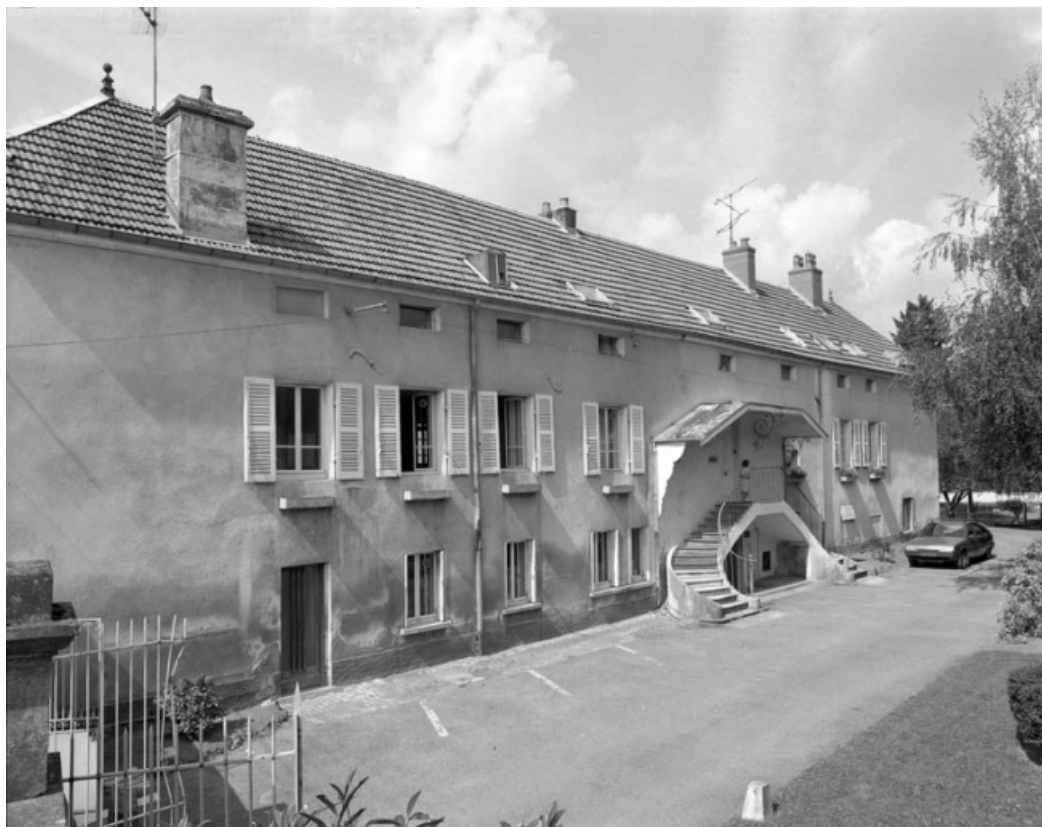
Façade latérale droite.
