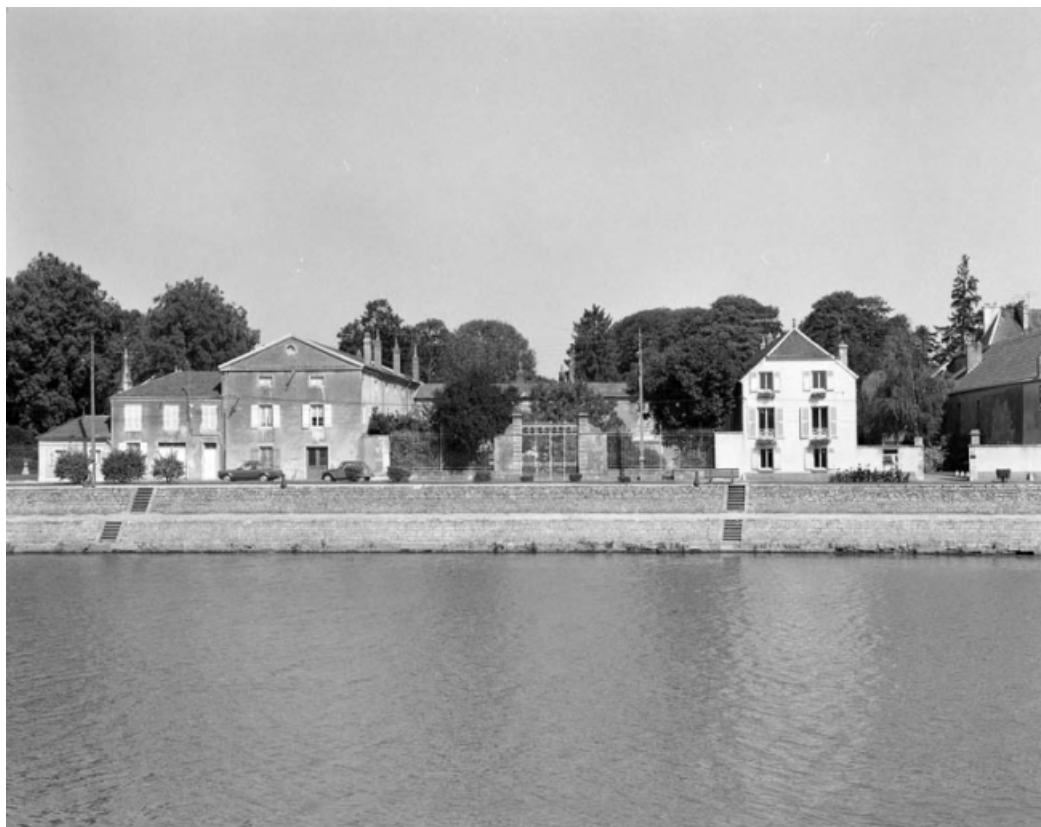
Vue d'ensemble depuis le quai Mavia.
