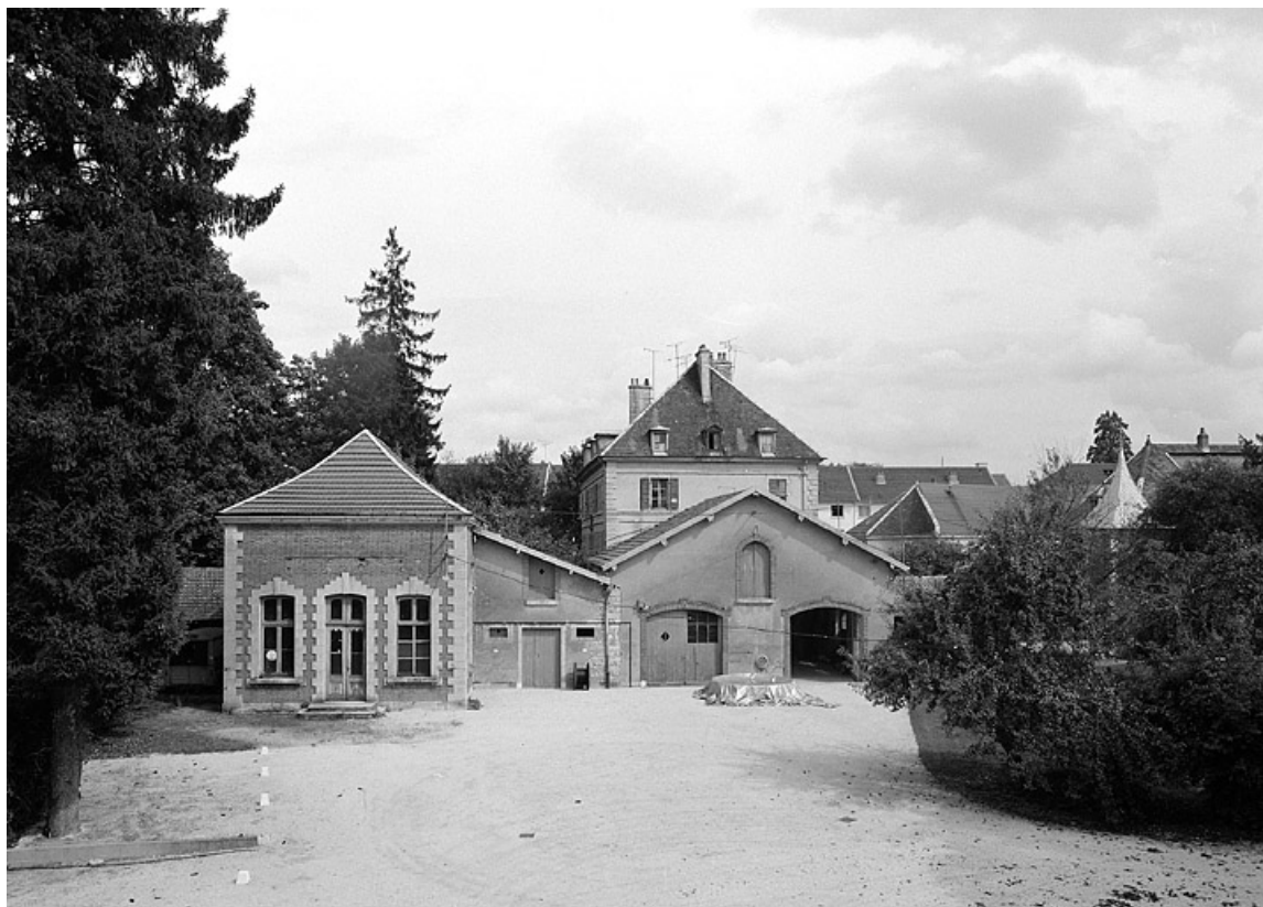
Remises et dépendances à droite de l'arrière-cour.
