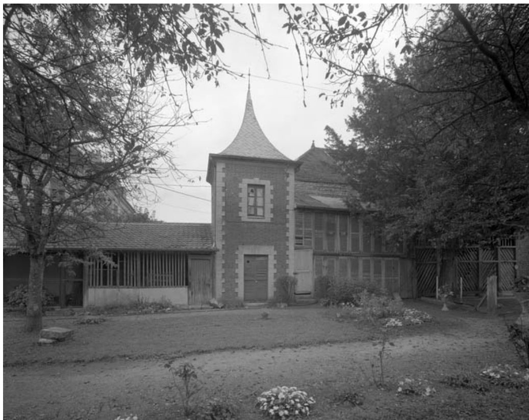
Bûchers et pigeonnier à droite de l'arrière-cour.
