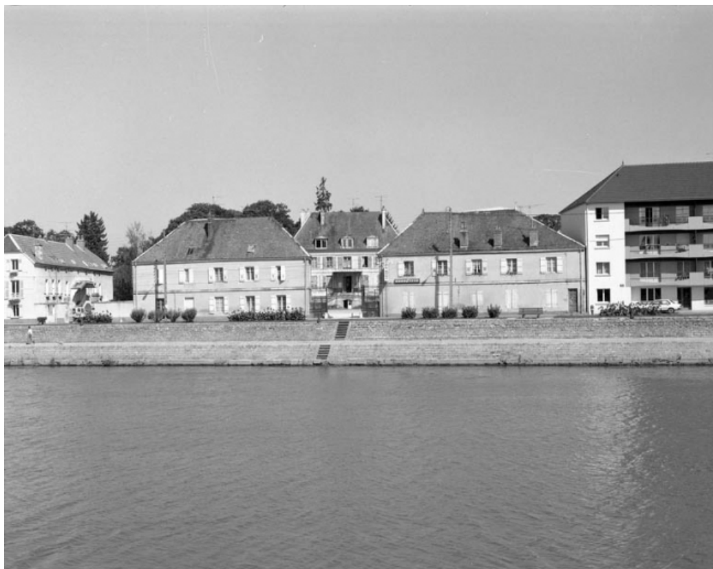
Vue d'ensemble de face depuis le quai Mavia.
