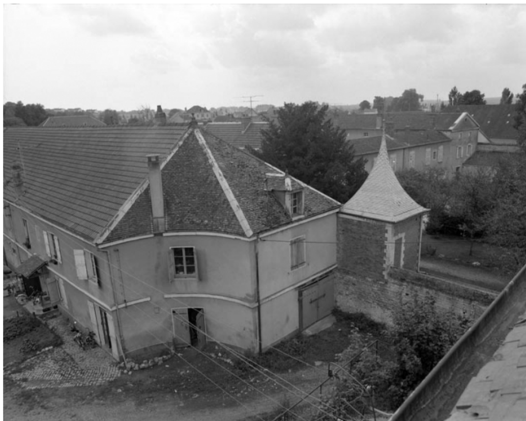
Détail de la façade latérale droite de l'entrepôt à gauche de la cour.
