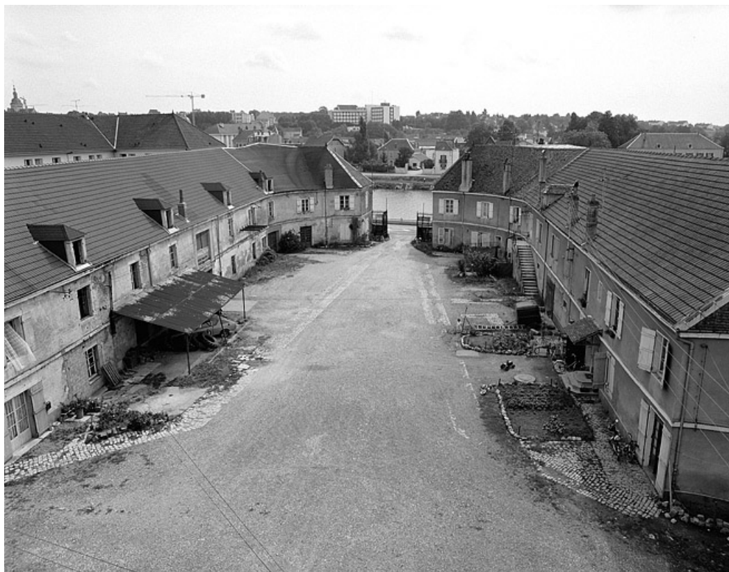
Vue d'ensemble des parties commerciales depuis l'habitation.
