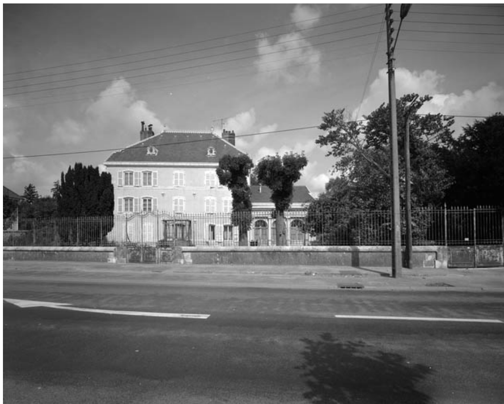
Vue d'ensemble de face, avec la rue Villeneuve au premier plan.
