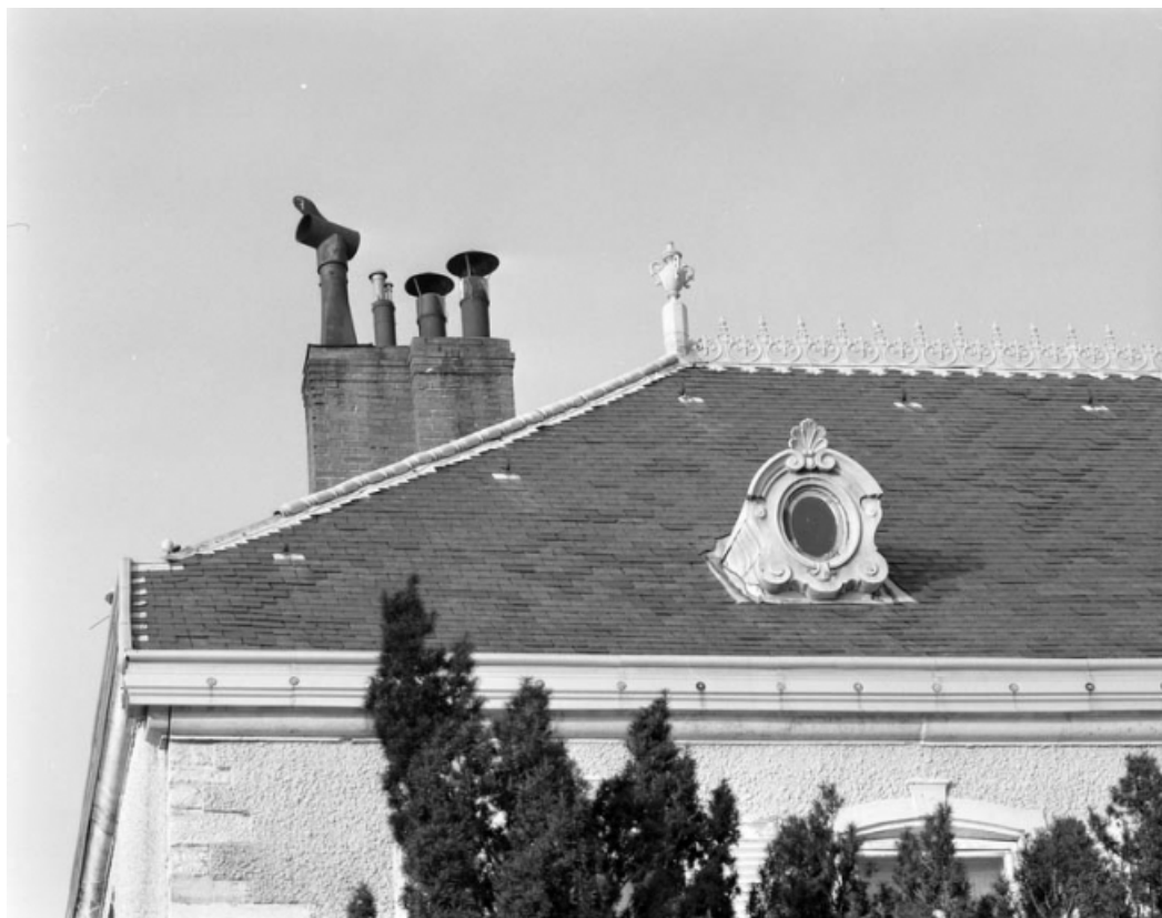
Détail d'une lucarne du toit de l'habitation.
