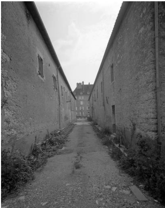
Vue des parties artisanales, depuis le fond de la parcelle.
