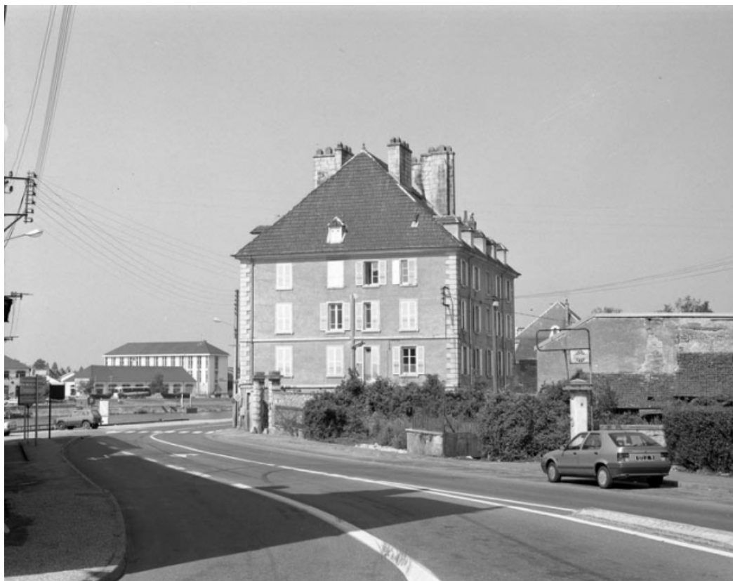
Vue de la façade latérale droite.
