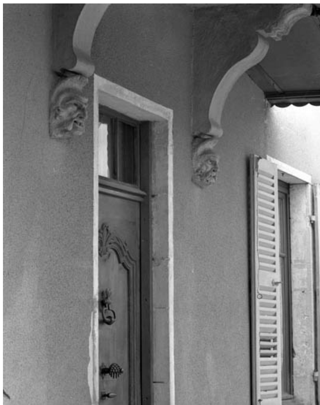
Détail des sculptures des supports soutenant le balcon.
