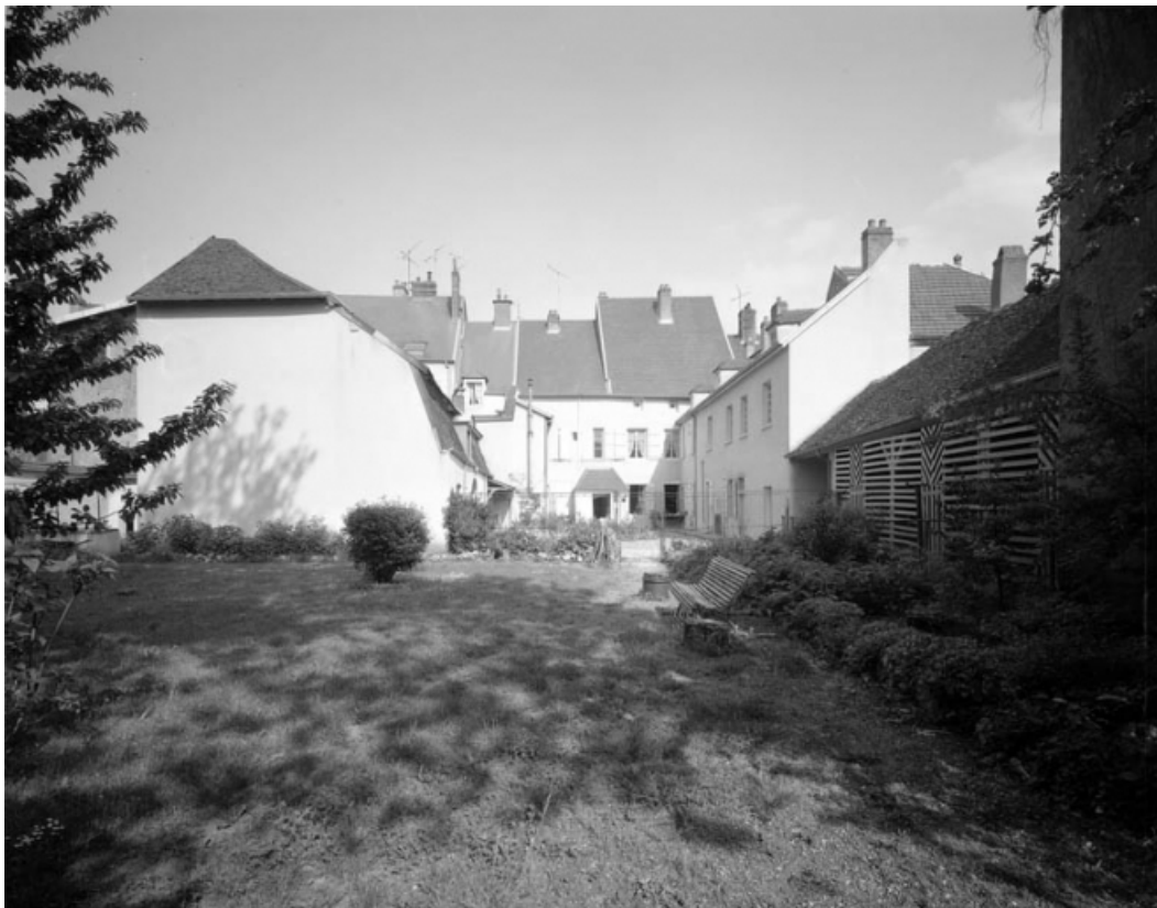
Façade postérieure : vue éloignée.
