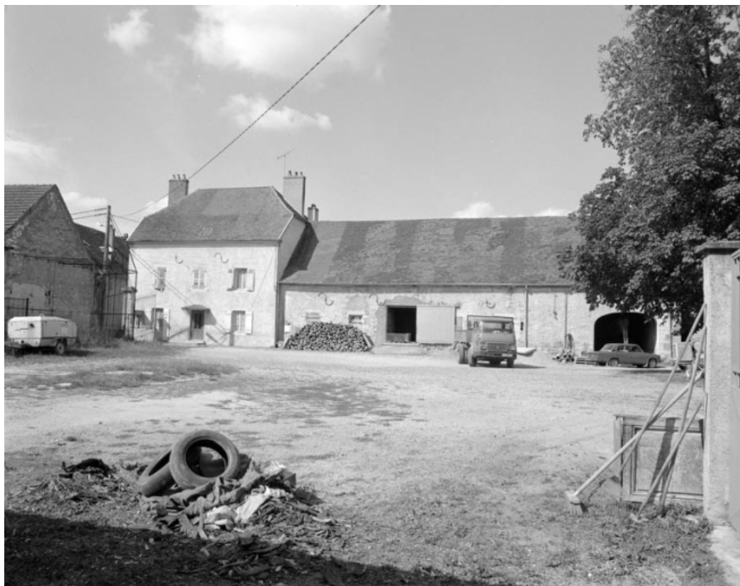
Vue des bâtiments à gauche de la cour : de face.
