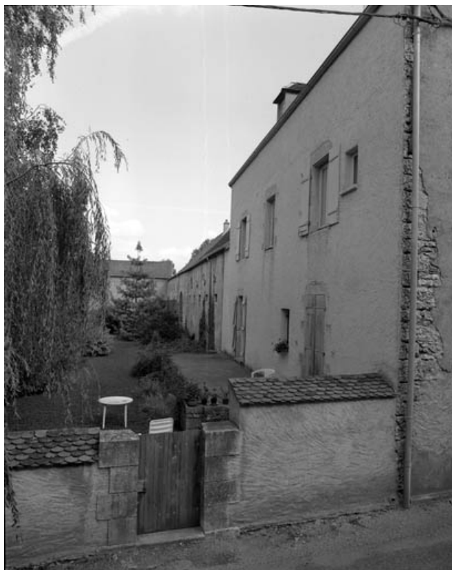
Façades postérieures des bâtiments situés à gauche de la cour.
