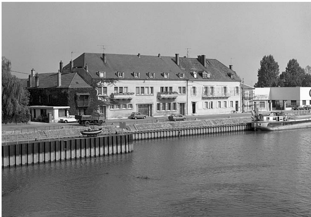
Vue d'ensemble de trois quarts gauche, depuis le pont sur la Saône. 70, Gray, 5, 6 quai Vergy
