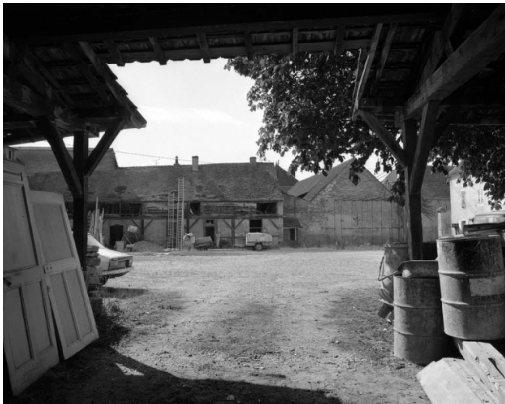
Bâtiments annexes à droite de la cour.
