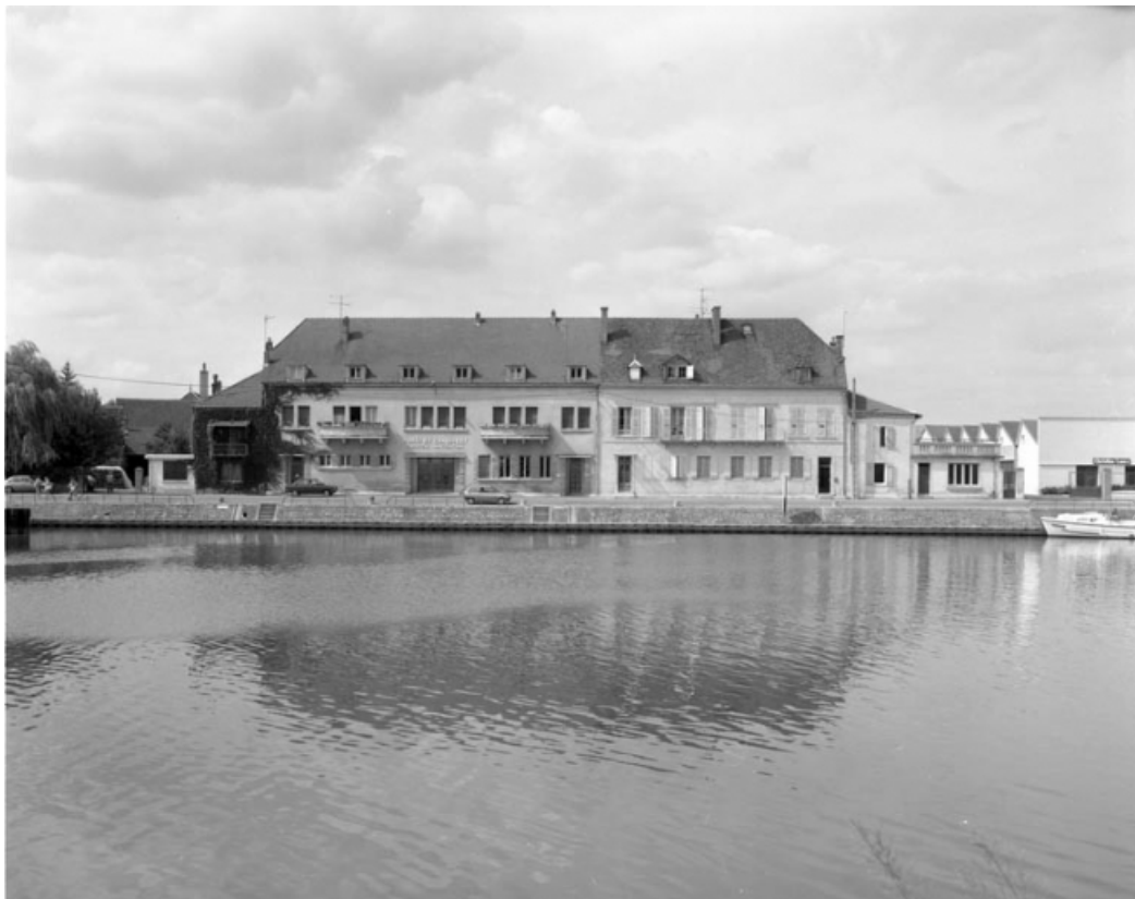
Vue d'ensemble depuis la rive gauche de la Saône.
