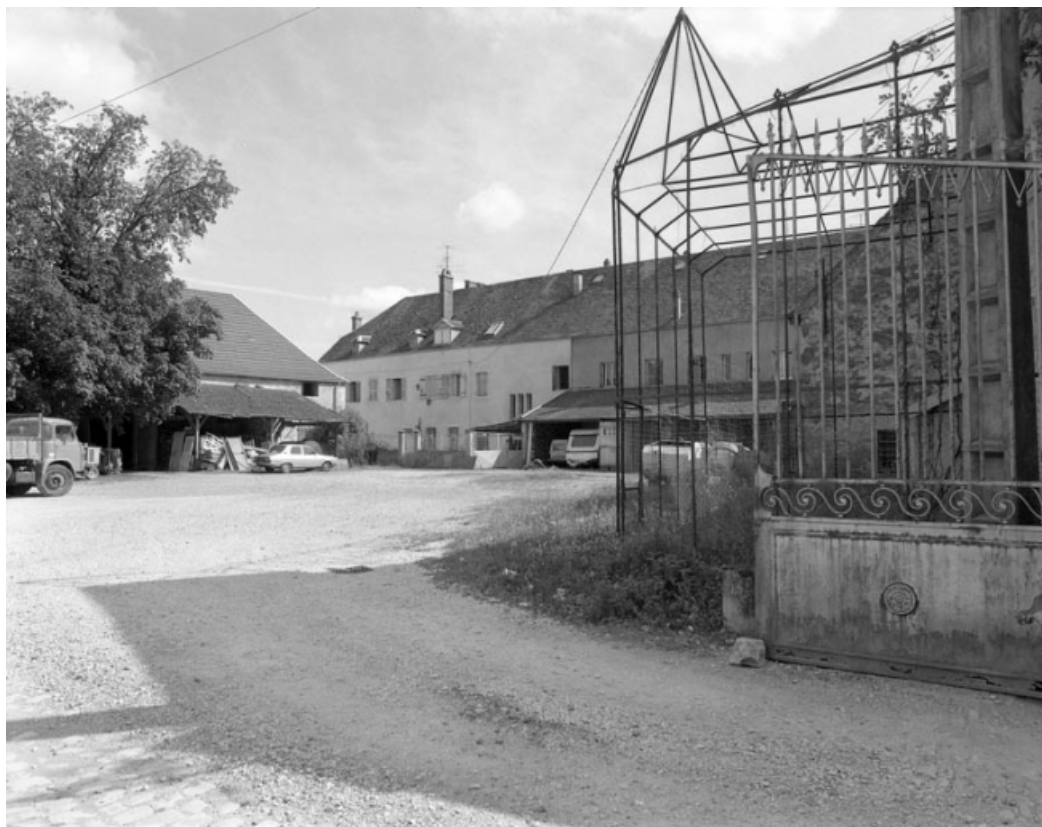
Vue d'ensemble de la cour depuis le portail d'entrée.
