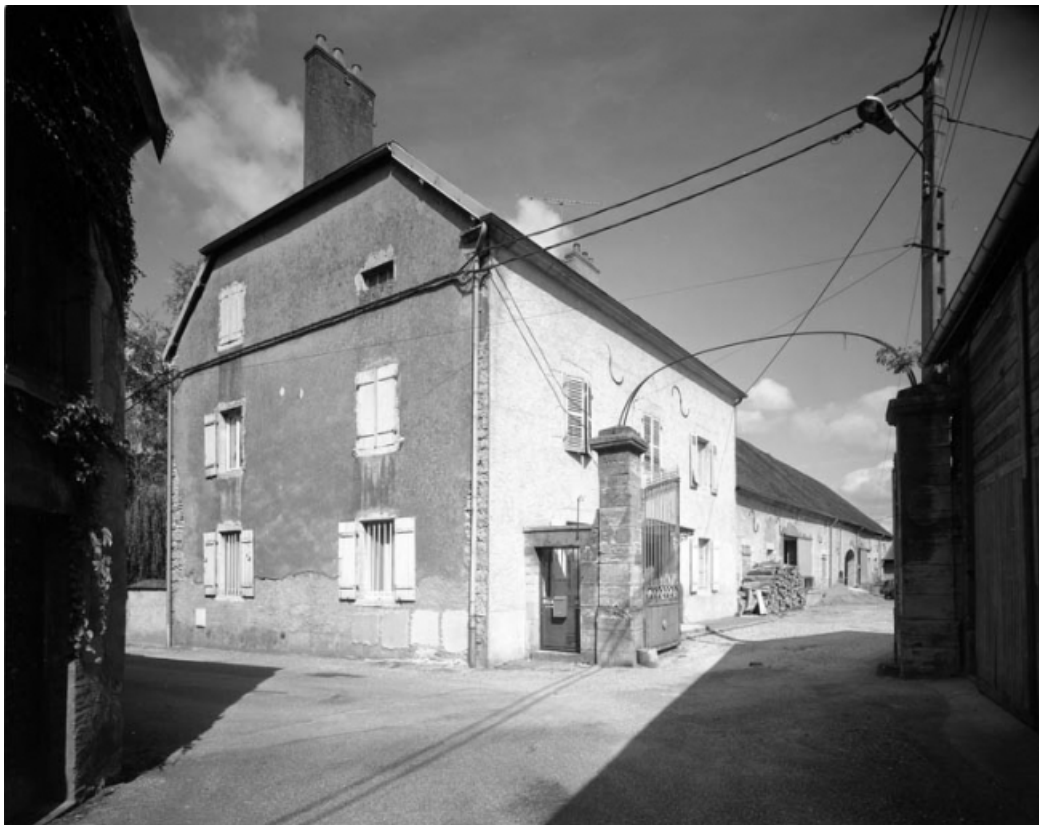
Vue des anciens bureaux, habitation et entrepôts, à gauche de la cour. 70, Gray, 5, 6 quai Vergy
