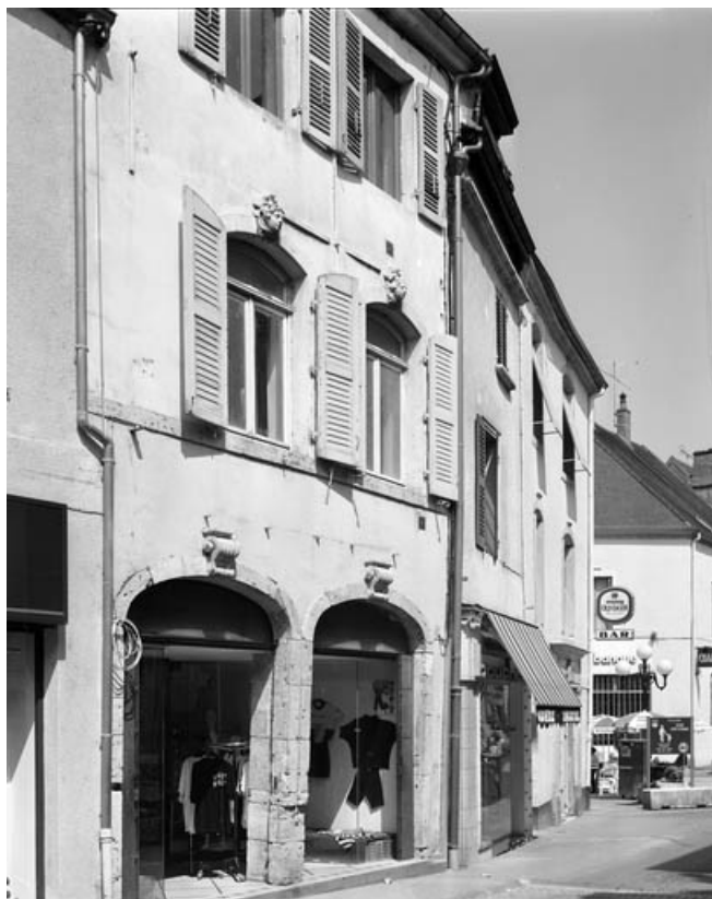
Façade antérieure : détail du rez de chaussée et du premier étage. 70, Gray, 13 rue Vanoise
