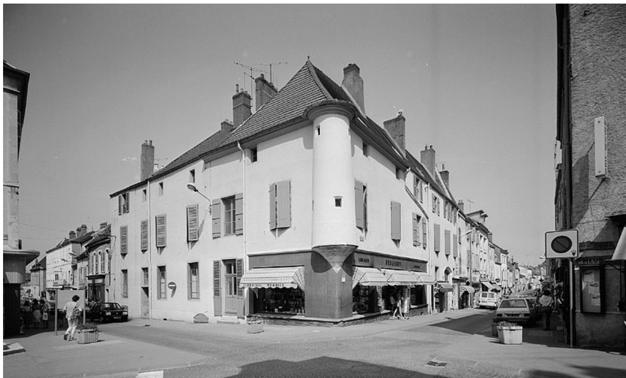
Vue d'ensemble depuis la place Edmond Bour.
