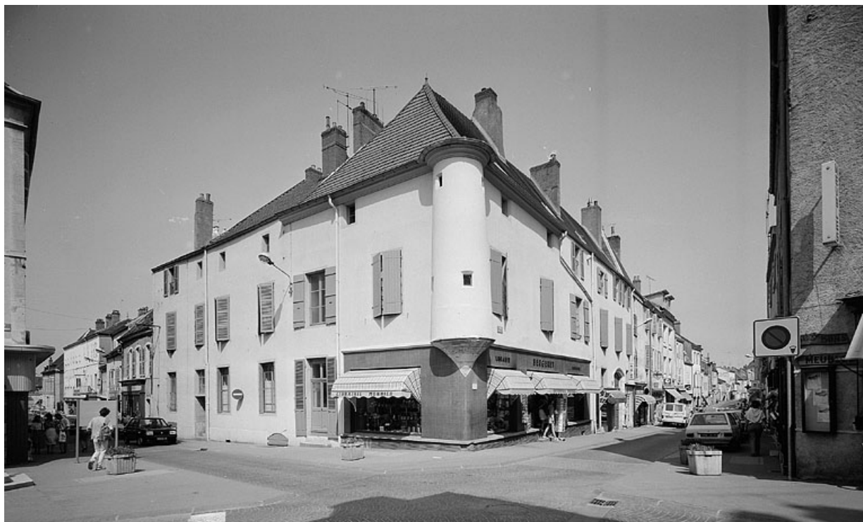
Vue d'ensemble depuis la place Edmond Bour.
