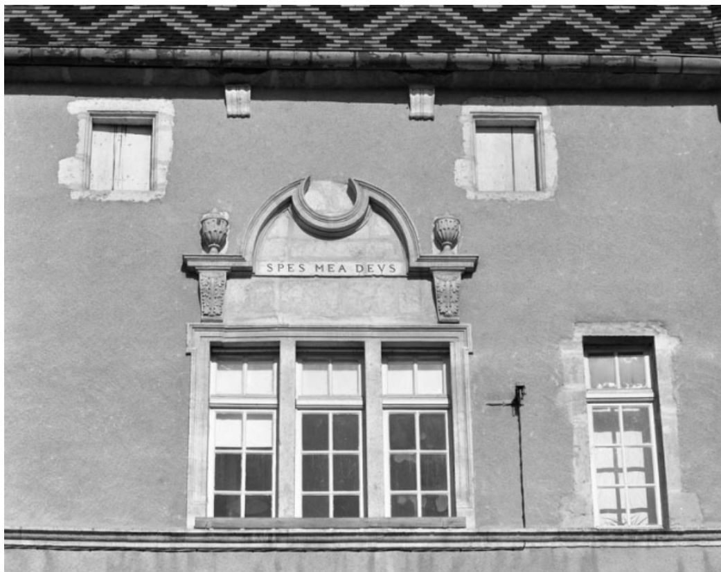
Façade antérieure : détail d'une baie du deuxième étage.
