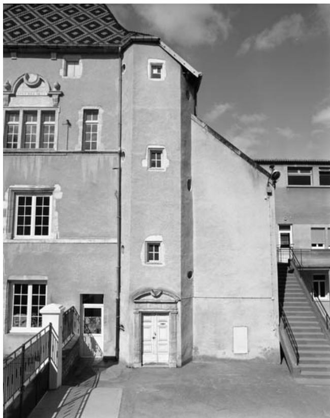
Détail de la tour d'escalier, de face.
