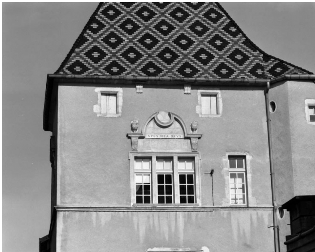
Façade antérieure : détail d'une baie du deuxième étage.
