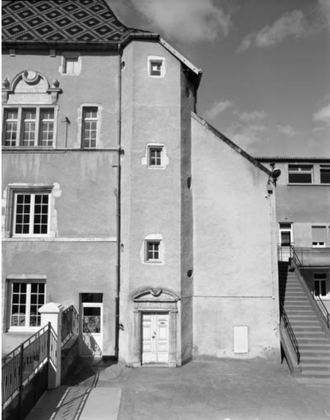
Détail de la tour d'escalier, de face.
