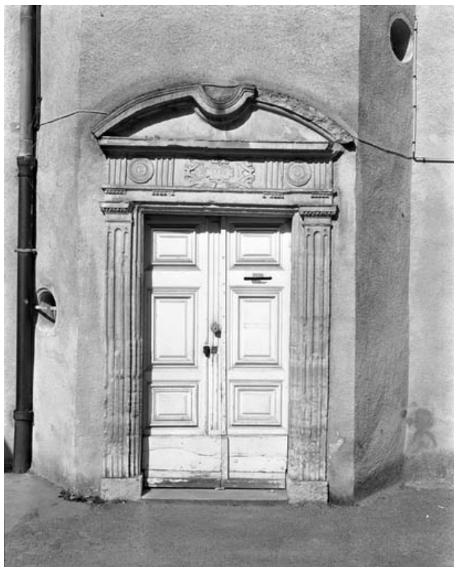
Détail de la porte d'entrée de l'escalier.
