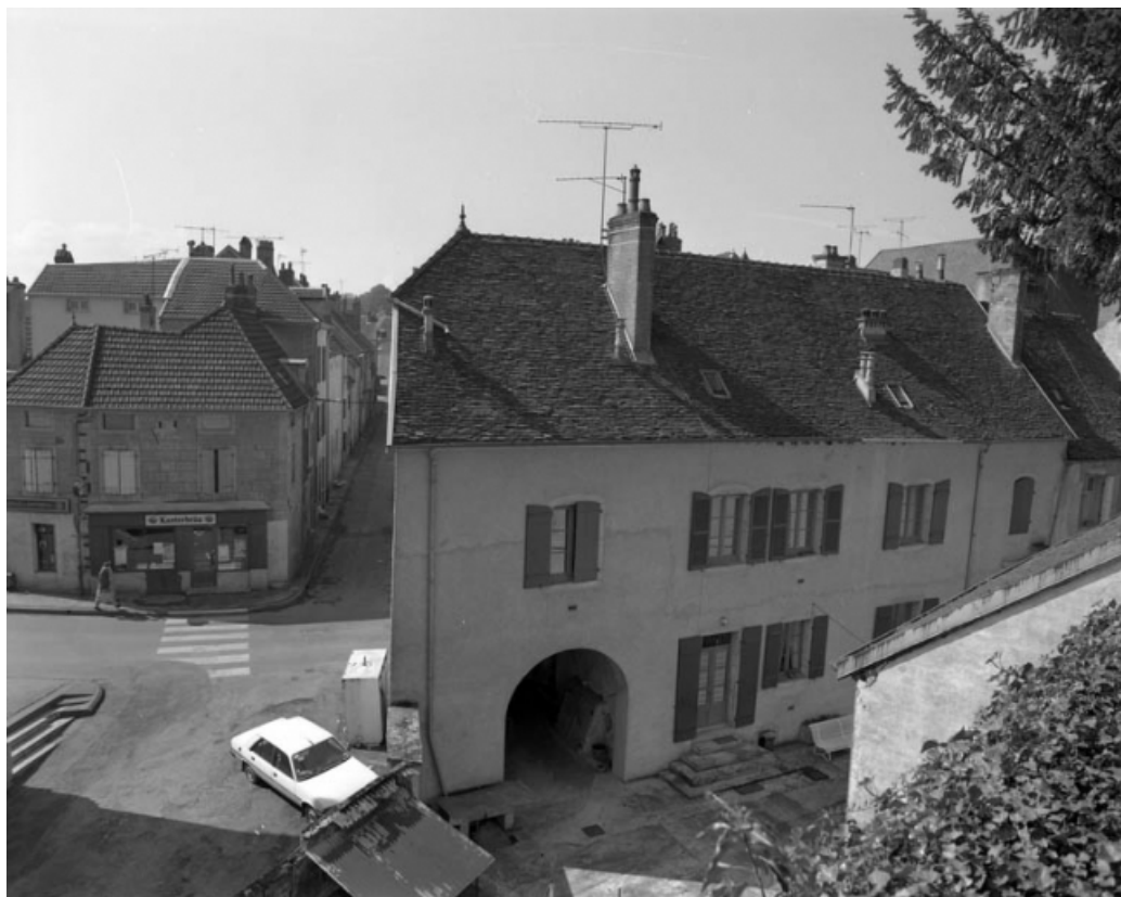
Façade postérieure en vue plongeante.
