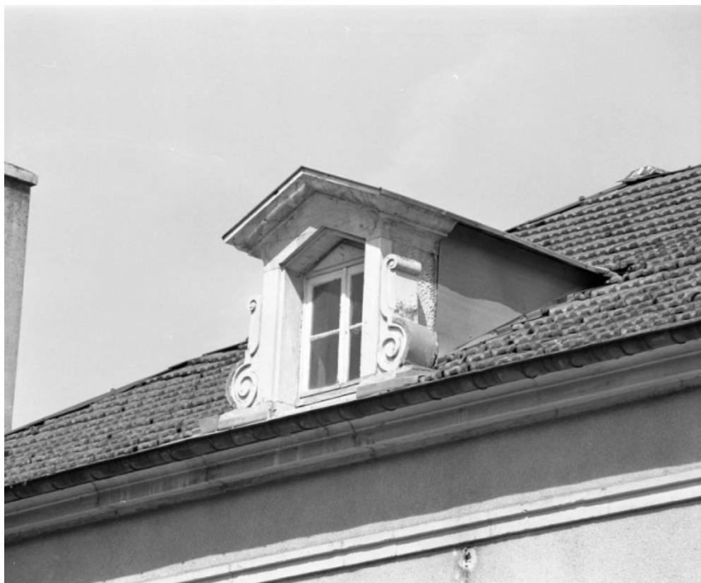
Détail d'une lucarne.
