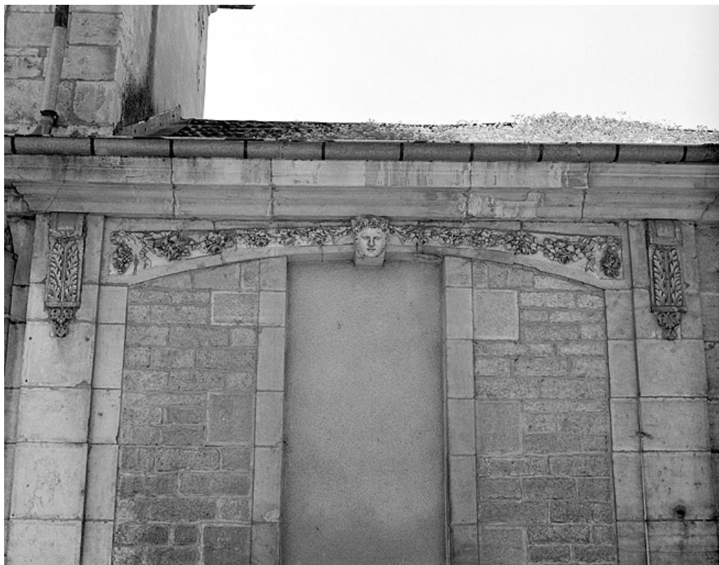
Détail du mur d'enclos côté Grande Rue.
