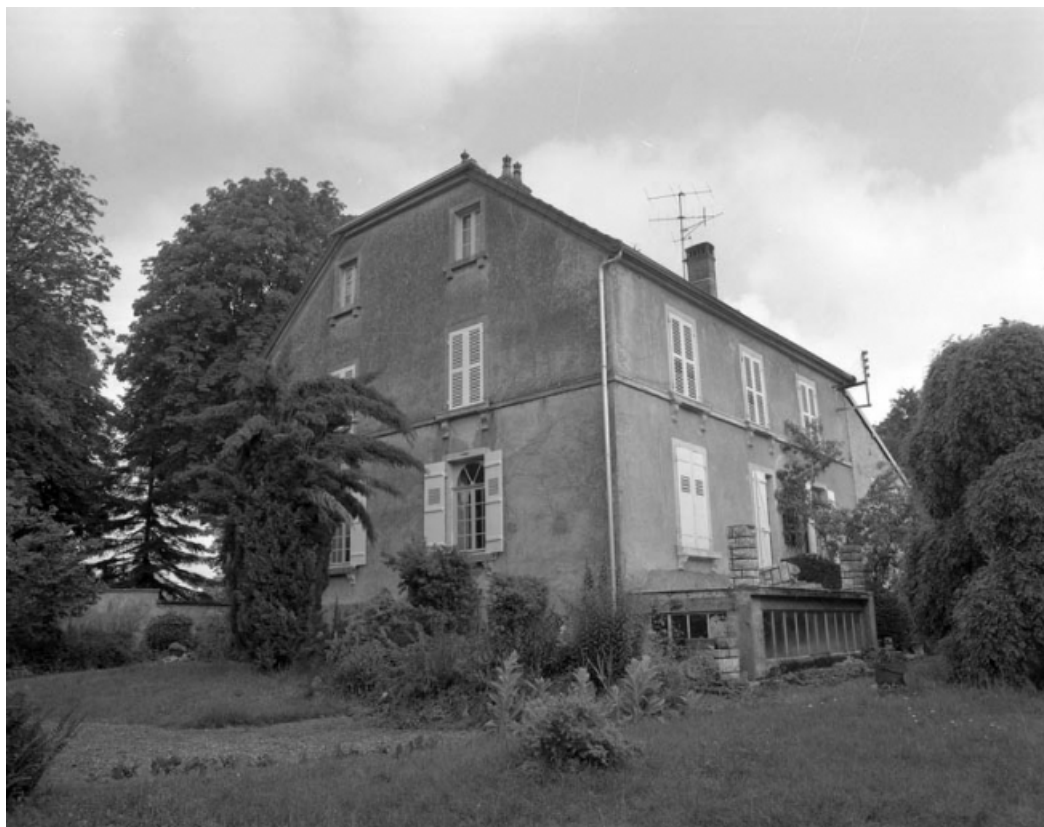
Façades postérieures et latérales droite.
