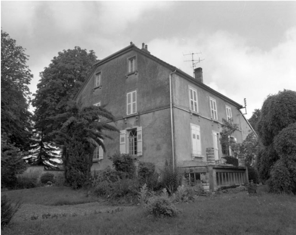
Façades postérieures et latérales droite.
