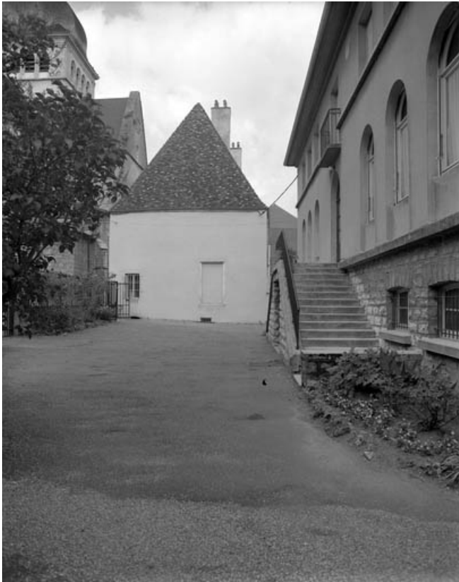
Façade latérale droite.
