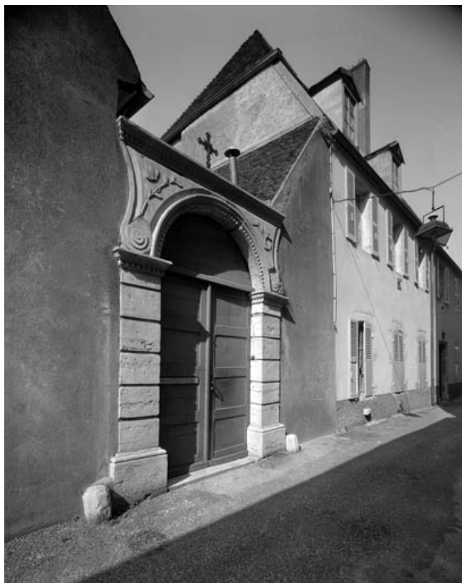
Le portail d'entrée de la cour.
