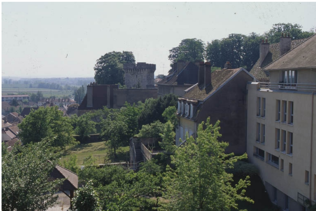
Vue de la façade postérieure et du jardin.
