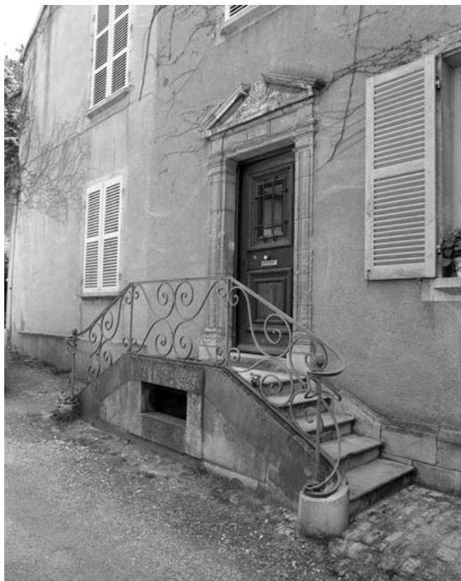
Façades postérieure et latérale droite de trois quarts droit.
