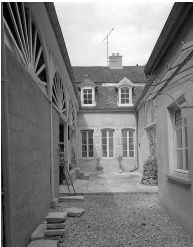
Façade antérieure de l'habitation et dépendances depuis l'entrée de la cour. 70, Gray, 1 rue Pigalle
