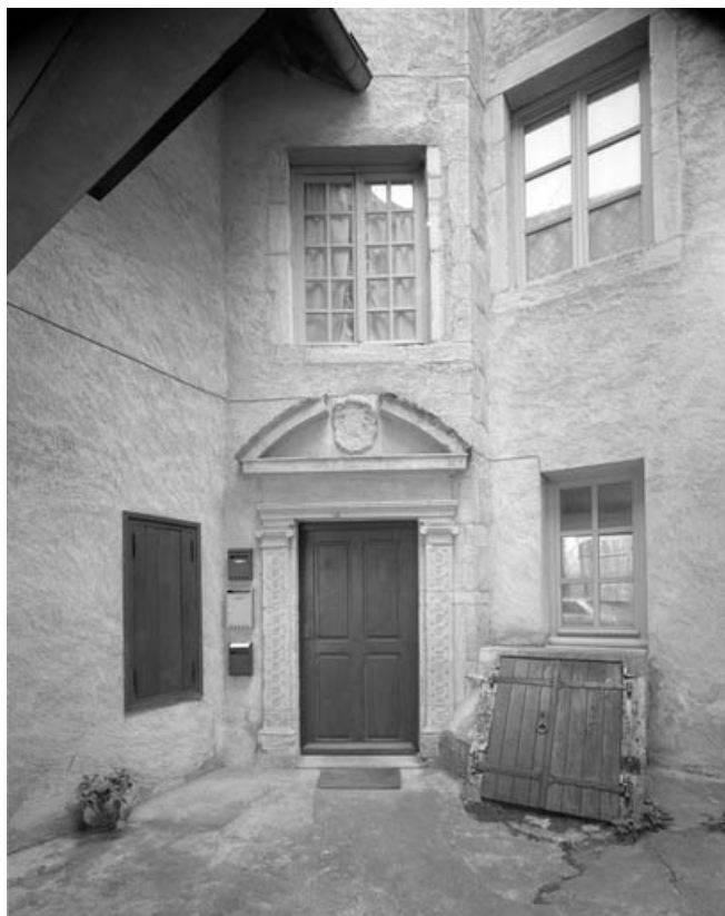
Détail : porte d'entrée de l'escalier en vis.
