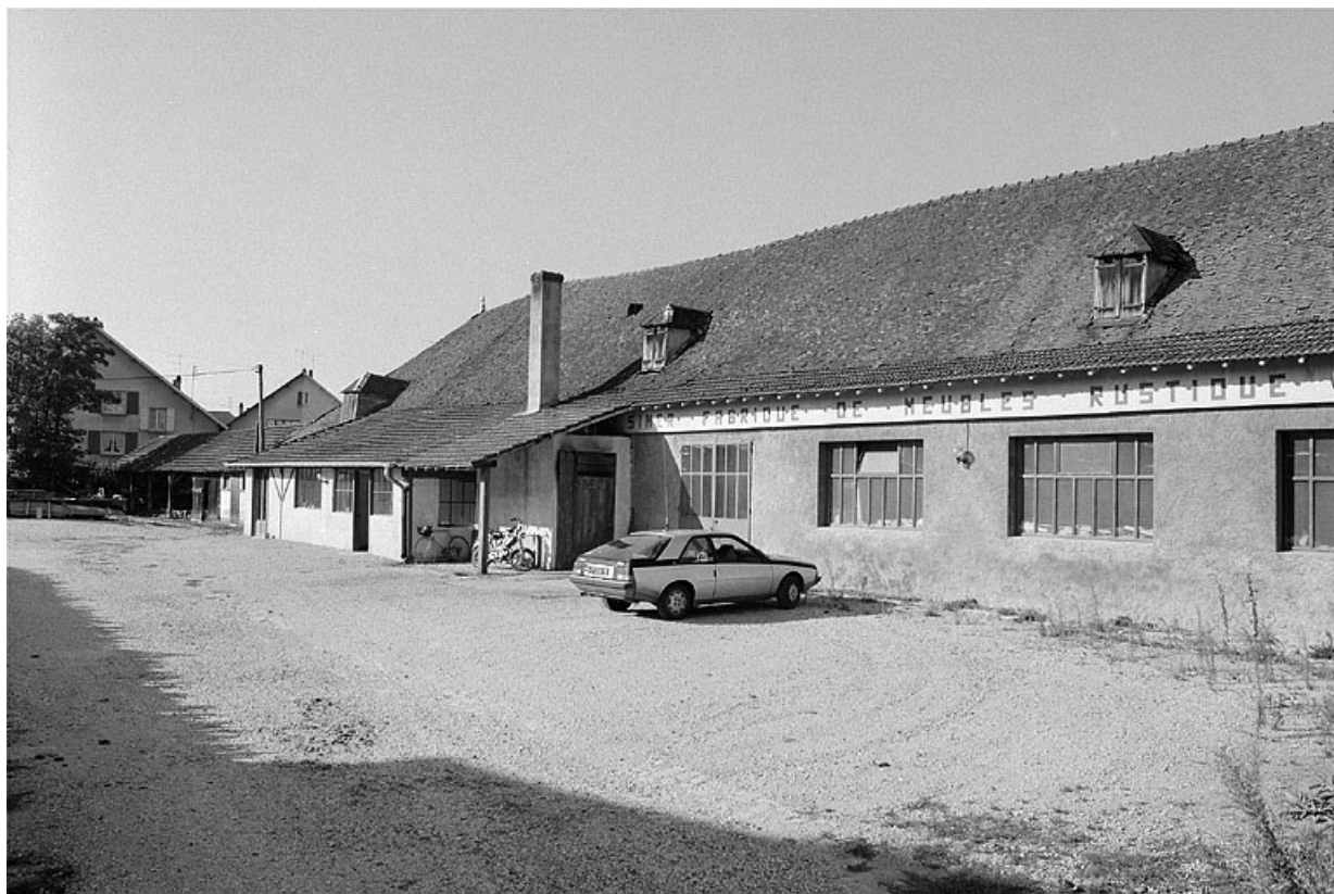
Anciens chais transformés en fabrique de meubles, depuis l'entrée de la cour des numéros 23 et 24. 70, Gray, 20, 23, 24 quai Mavia
