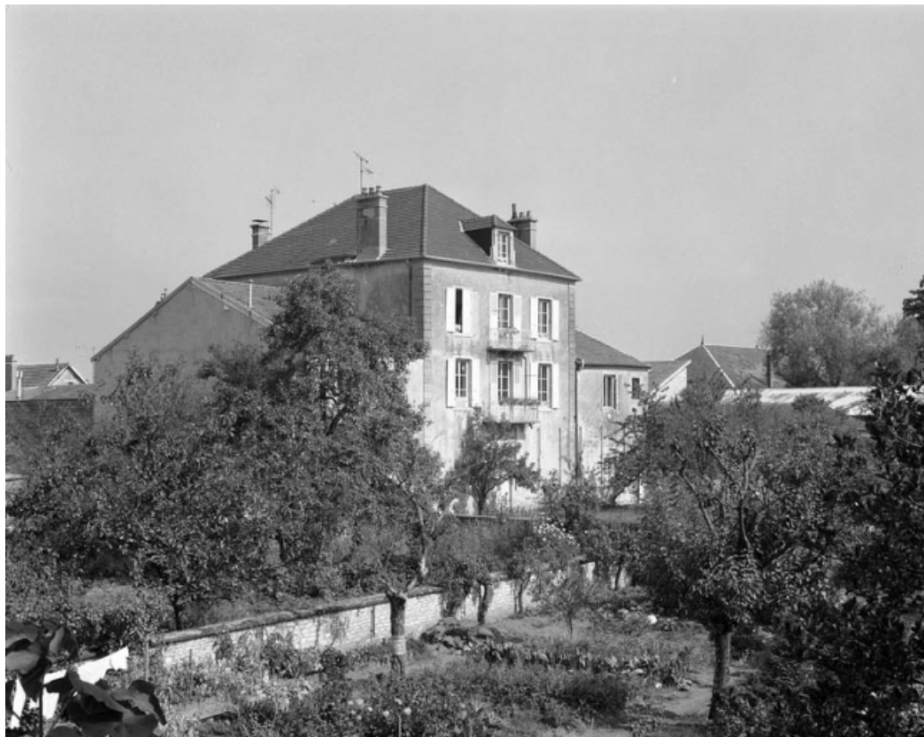
Façade postérieure de l'habitation de trois quarts gauche.
