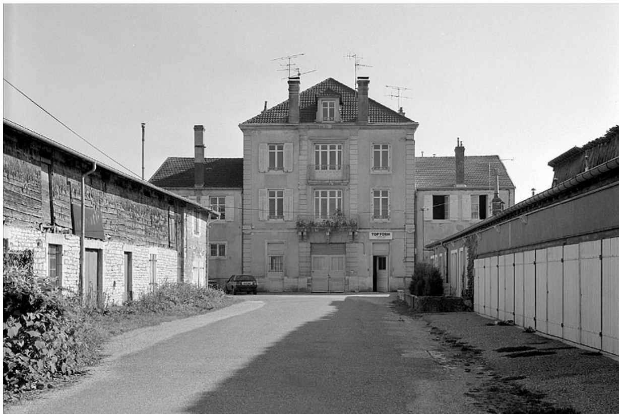
Vue d'ensemble de l'habitation, de face.
