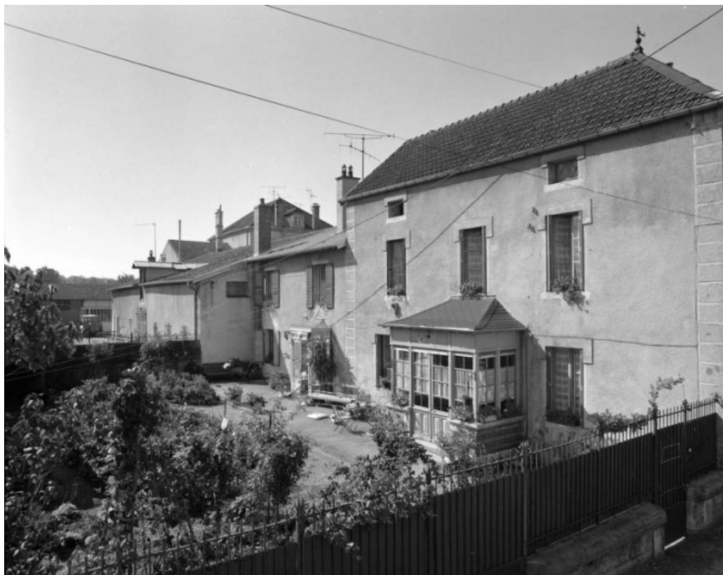
Vue de l'habitation appuyée contre le chais gauche, depuis le quai Mavia. 70, Gray, 18, 19 quai Mavia
