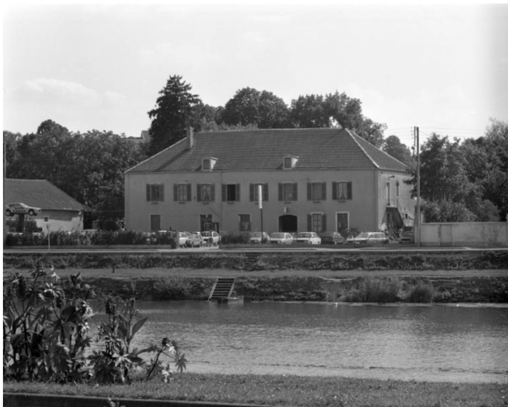
Le bâtiment principal depuis le quai Villeneuve.
