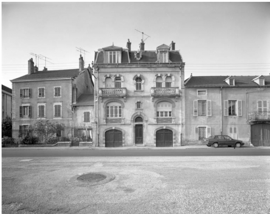
Façade antérieure de face, depuis le quai Mavia.
