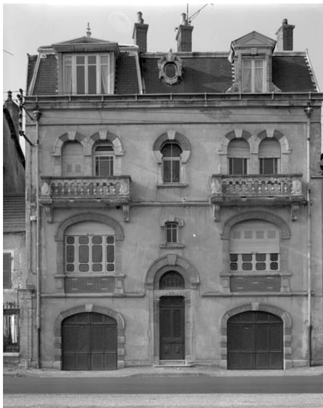
Façade antérieure de face, vue rapprochée.
