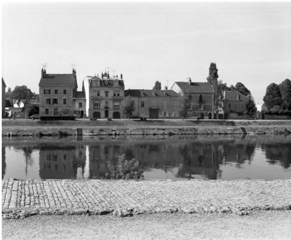
Vue d'ensemble de l'édifice avec les maisons voisines, depuis le quai Villeneuve. 70, Gray, 10 quai Mavia
