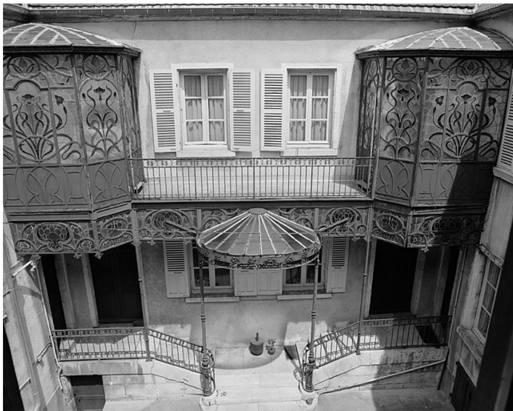
Façade antérieure sur cour, de face, vue plongeante.
