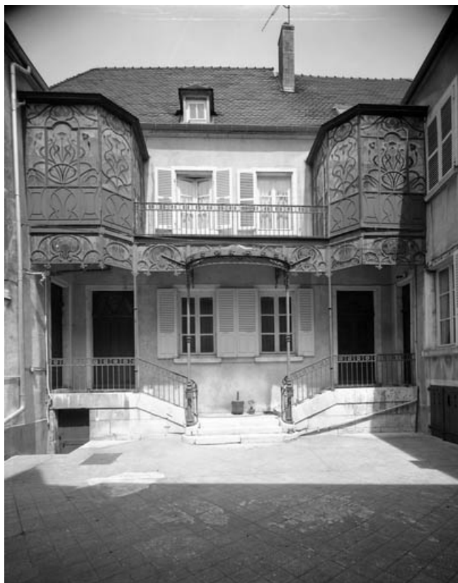
Façade antérieure sur cour, de face.
