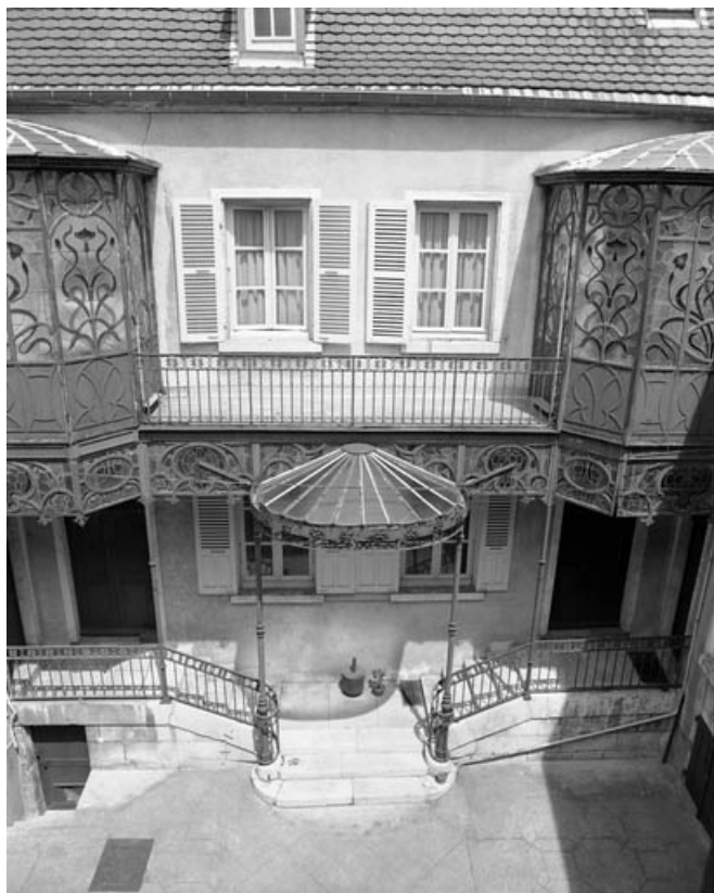
Façade antérieure sur cour, de face, vue plongeante.
