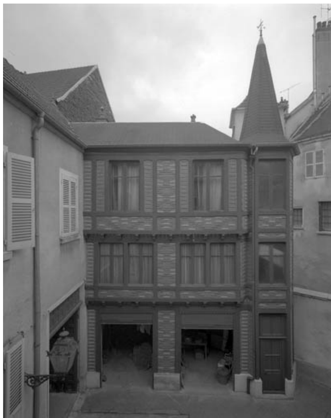
Corps de bâtiment situé à droite de la porte d'entrée de la cour : vu de face. 70, Gray, 12 rue de la Malcouverte
