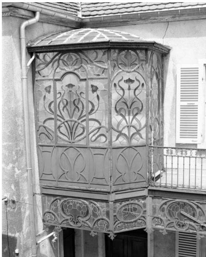
Façade antérieure sur cour : détail de la logette gauche.
