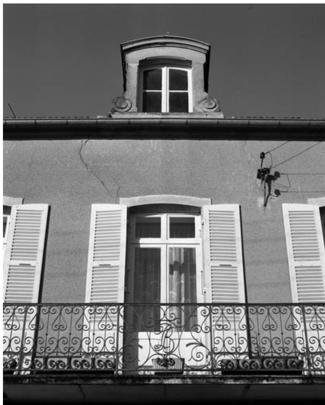
Détail du premier étage avec balcon en ferronnerie.
