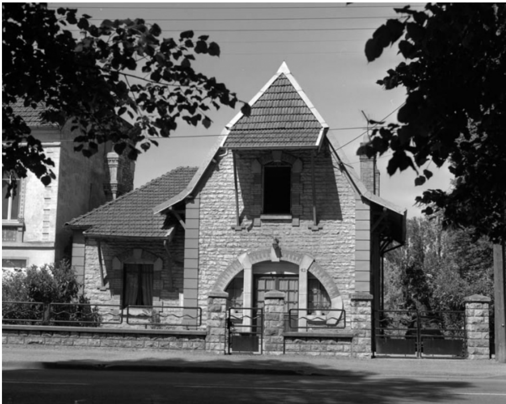
Façade antérieure, de face.
