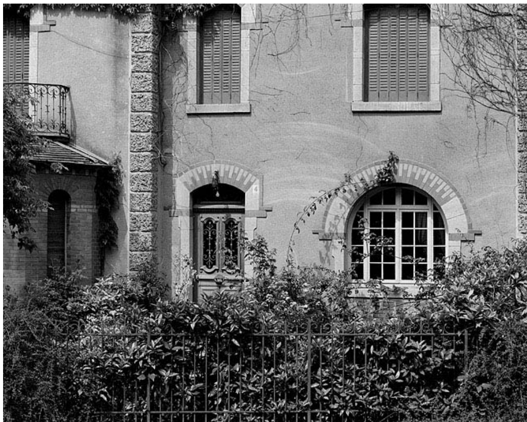
Façade antérieure : détail des baies du rez de chaussée.
