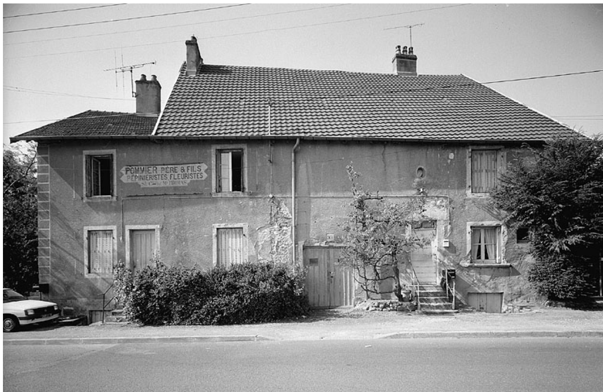
Façade antérieure, de face.
