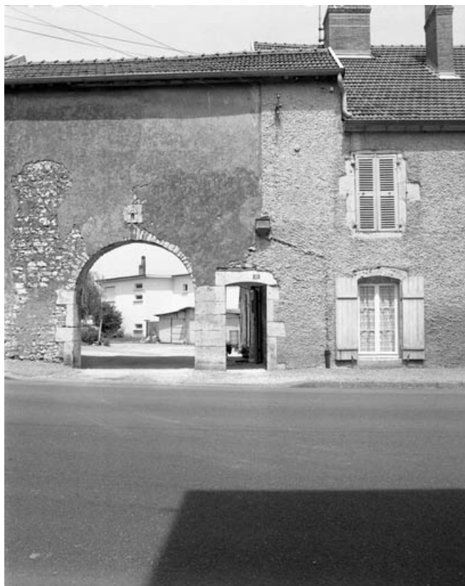
Aile gauche : détail de la porte d'entrée dans la cour.
