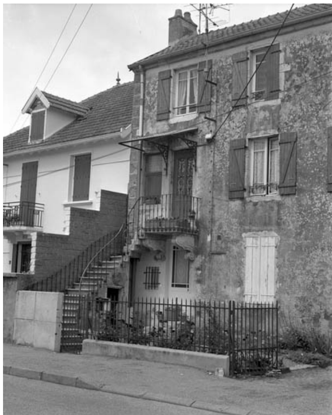
Détail de la partie gauche de la façade antérieure.
