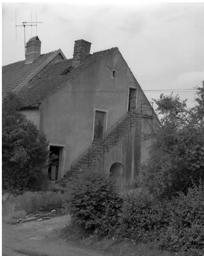
Façade antérieure sur pignon, de trois quarts gauche.
