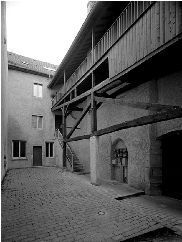
Galerie de liaison et façade postérieure du bâtiment sur rue. 70, Gray Grande Rue 83
