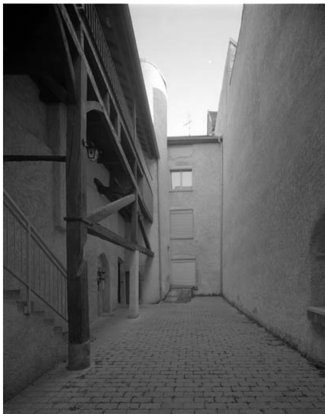
Galerie de liaison et façade antérieure du logement sur cour. 70, Gray Grande Rue 83
