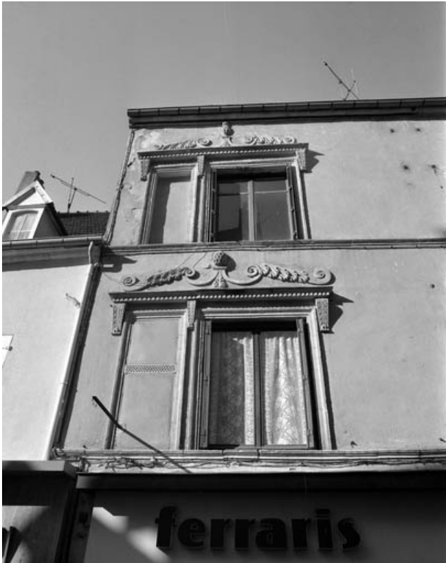
Détail : décor des baies des premier et deuxième étages. 70, Gray Grande Rue 99
