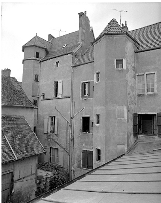
Façade postérieure depuis le toit de la dépendance droite. 70, Gray Grande Rue 99
