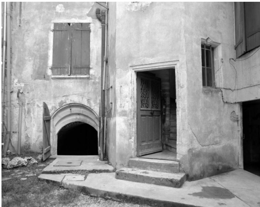
Détail des portes d'accès à la tour d'escalier et au sous-sol sur la façade postérieure. 70, Gray Grande Rue 99
