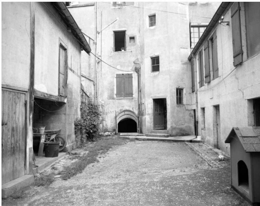
Façade postérieure et dépendance à droite et à gauche de la cour depuis le fond de la parcelle. 70, Gray Grande Rue 99
