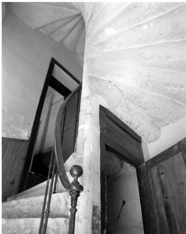
Détail de l'escalier en vis, dans l'aile sur cour.
