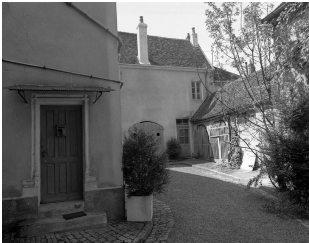
Logement sur cour et bûcher.
