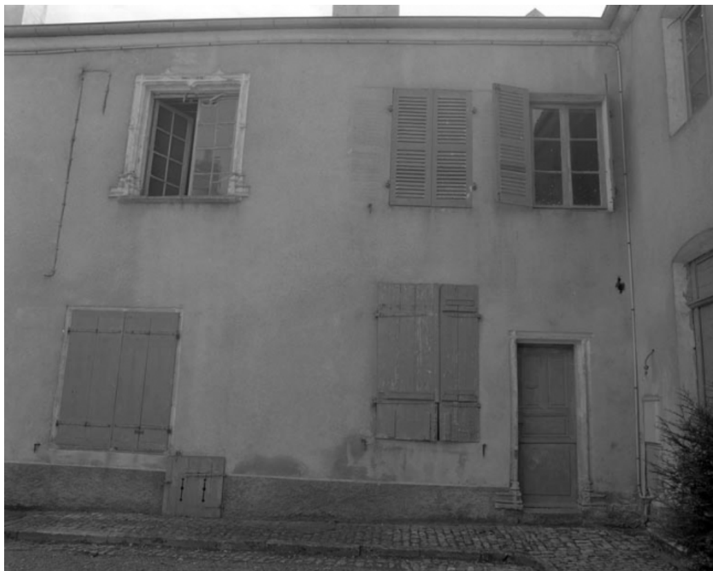
Façade antérieure du logement gauche sur cour.
