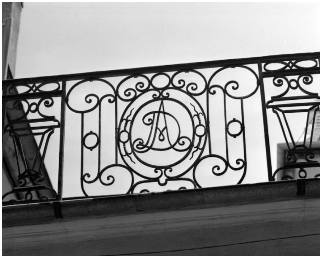
Portail d'entrée : détail du garde-corps en ferronnerie du passage découvert. 70, Gray Grande Rue 54
