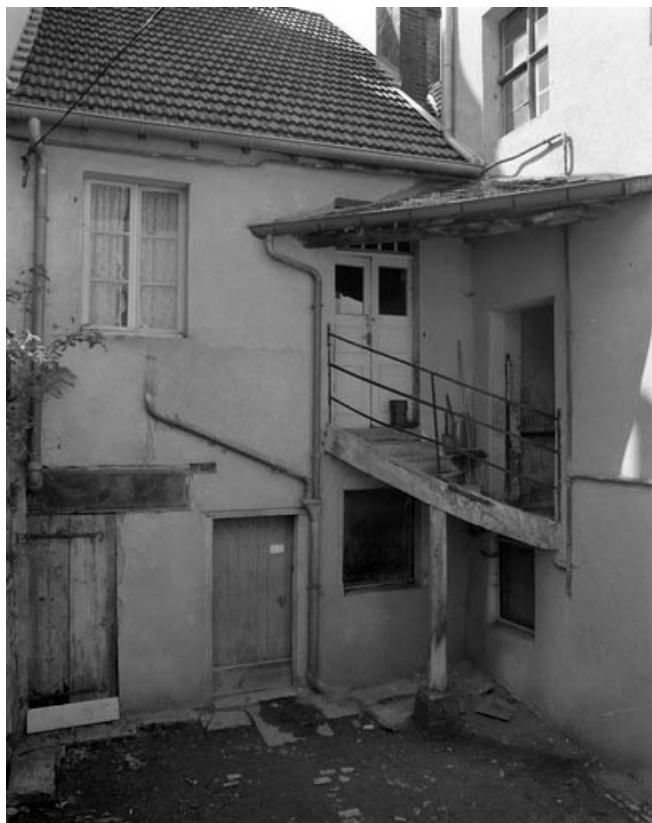
Détail du petit escalier desservant le logement en fond de cour, issu du grand escalier à retours sans jour. 70, Gray Grande Rue 54
