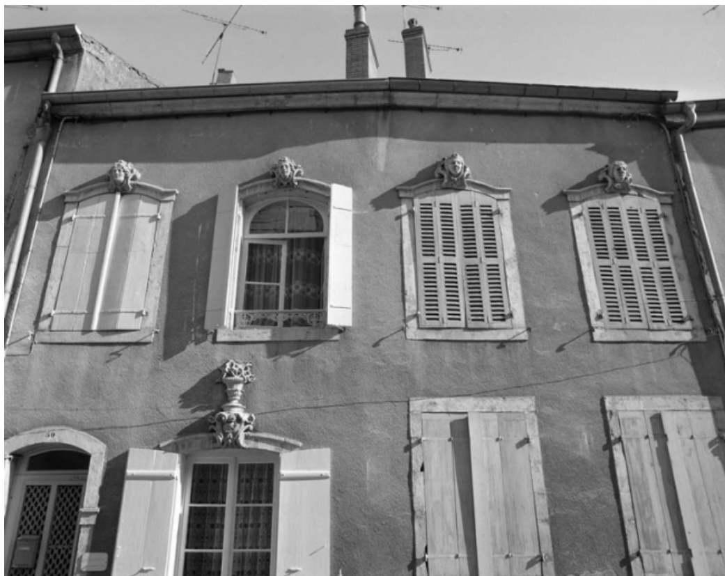
Façade antérieure : baies du premier étage.
