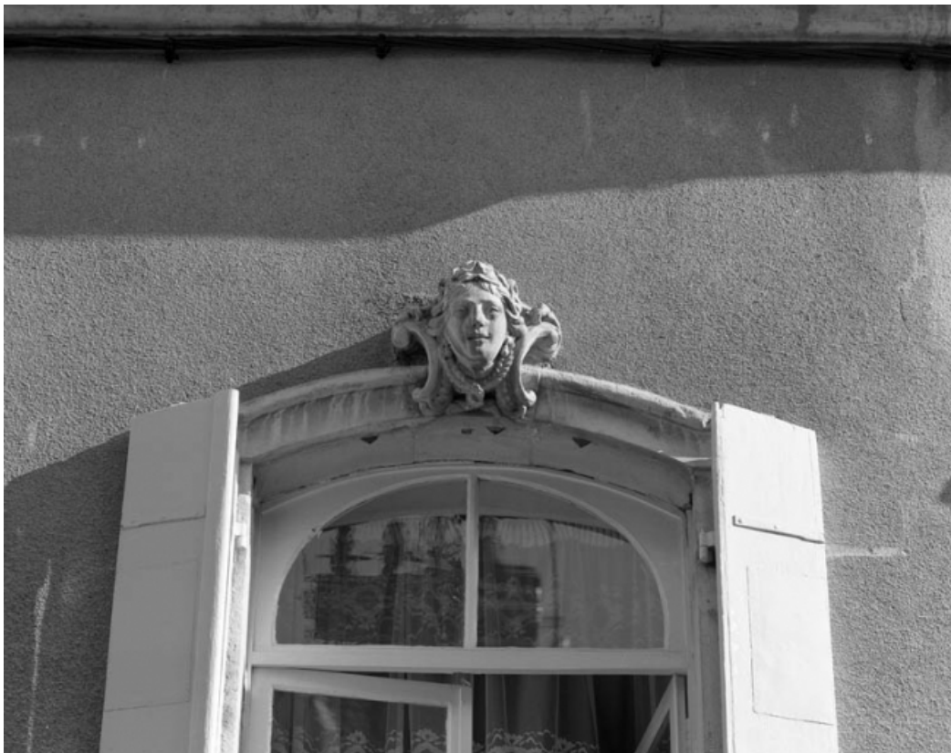
Façade antérieure : détail d'une agrafe d'une fenêtre du premier étage. 70, Gray Grande Rue 48, 50
