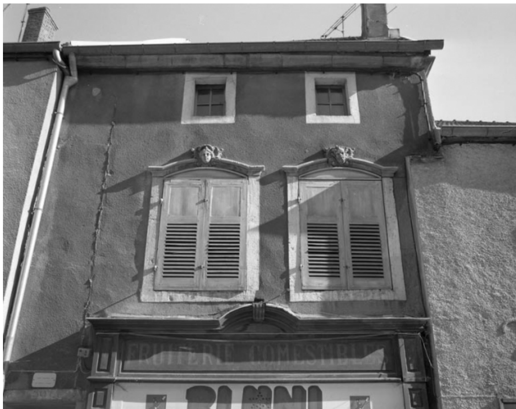
Façade antérieure : détail de la partie supérieure.
