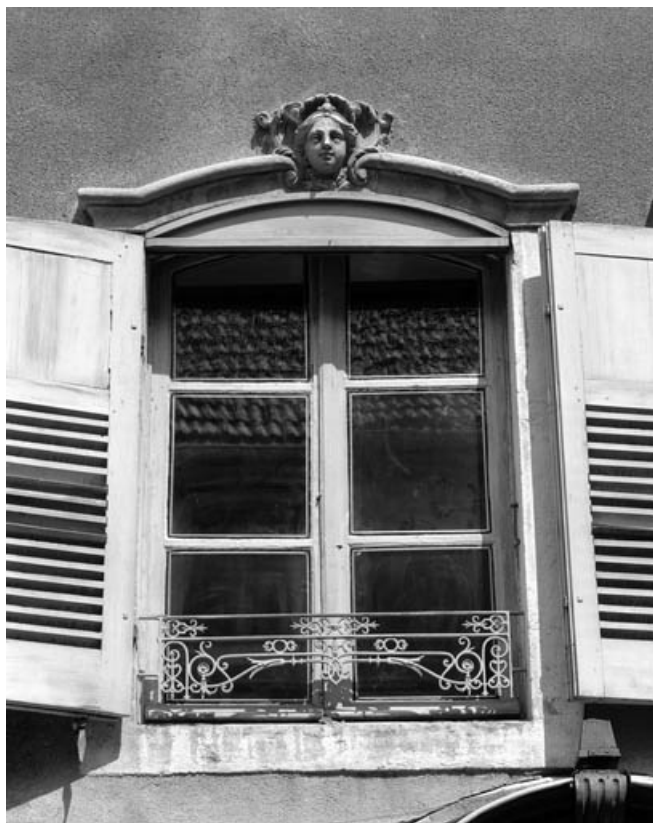
Façade antérieure : détail de la baie gauche du premier étage. 70, Gray Grande Rue 42
