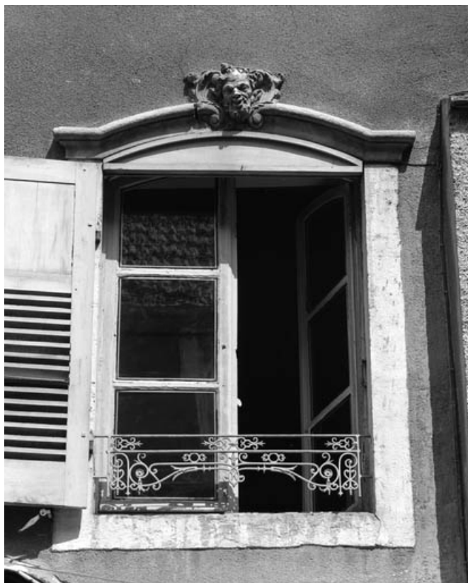
Façade antérieure : détail baie droite du premier étage.
