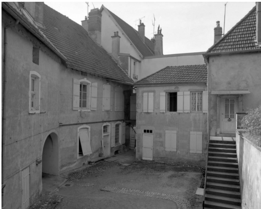
Façade postérieure à droite et logement gauche sur cour.
